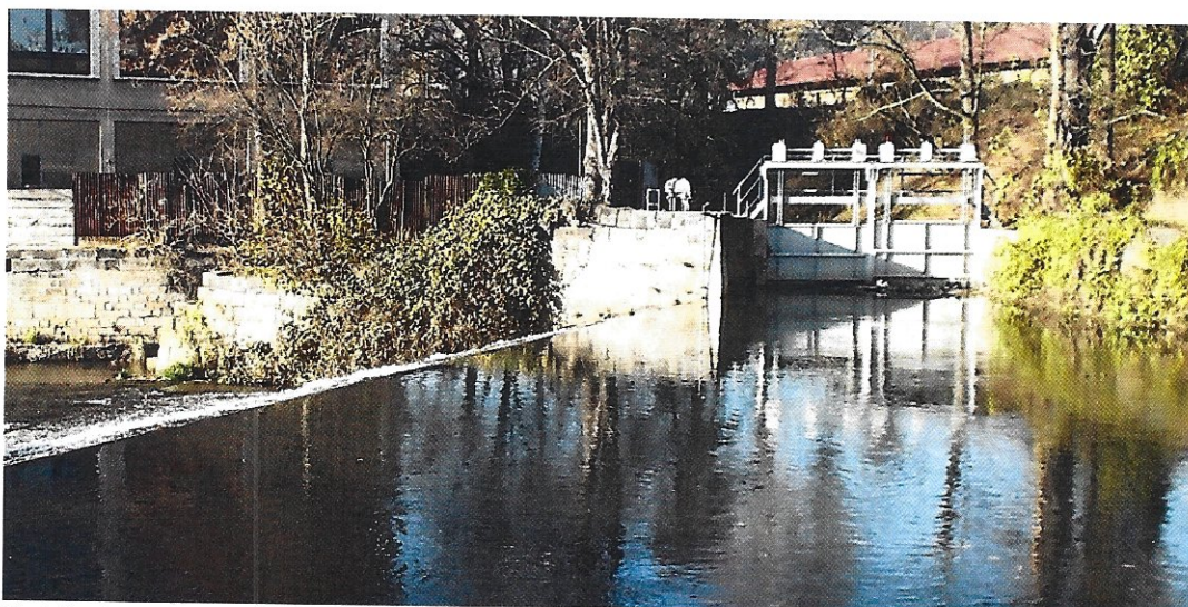
Pohled na pravobřežní zavázání jezu s nátokem do náhonu
