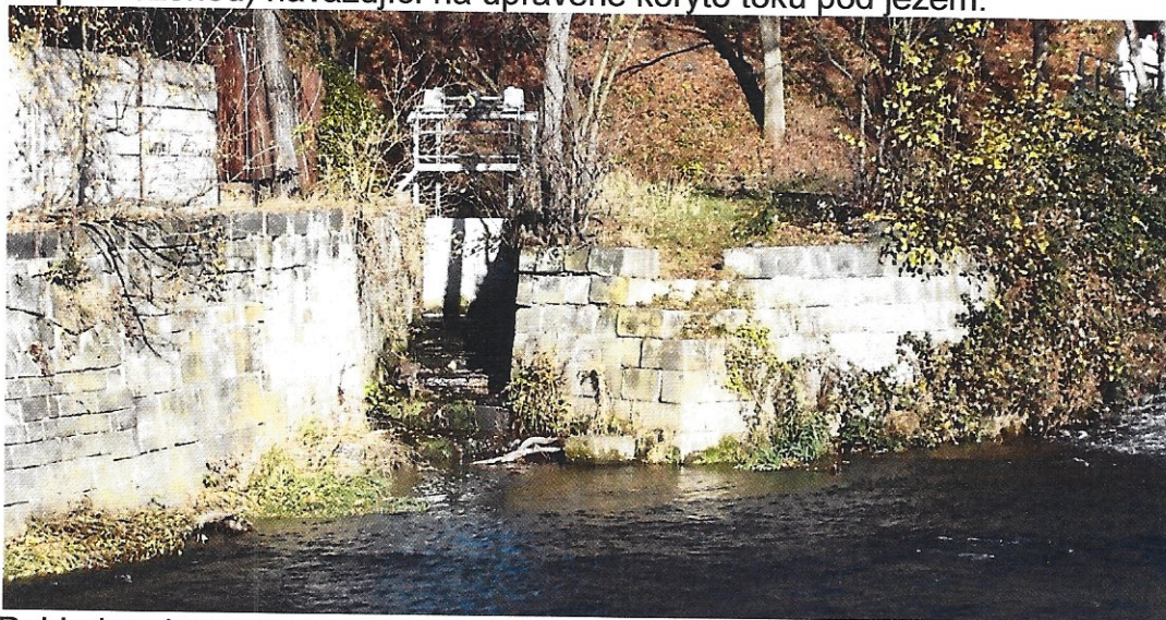
Pohled na koryto jalové propusti proti vodě
