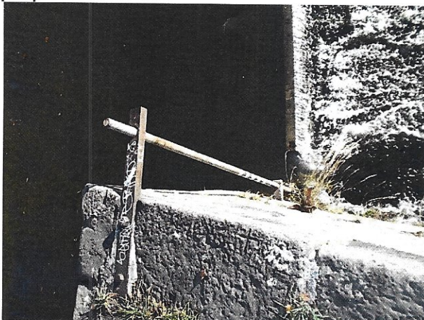
Nástavec na koruně jezu s manipulační klapkou
