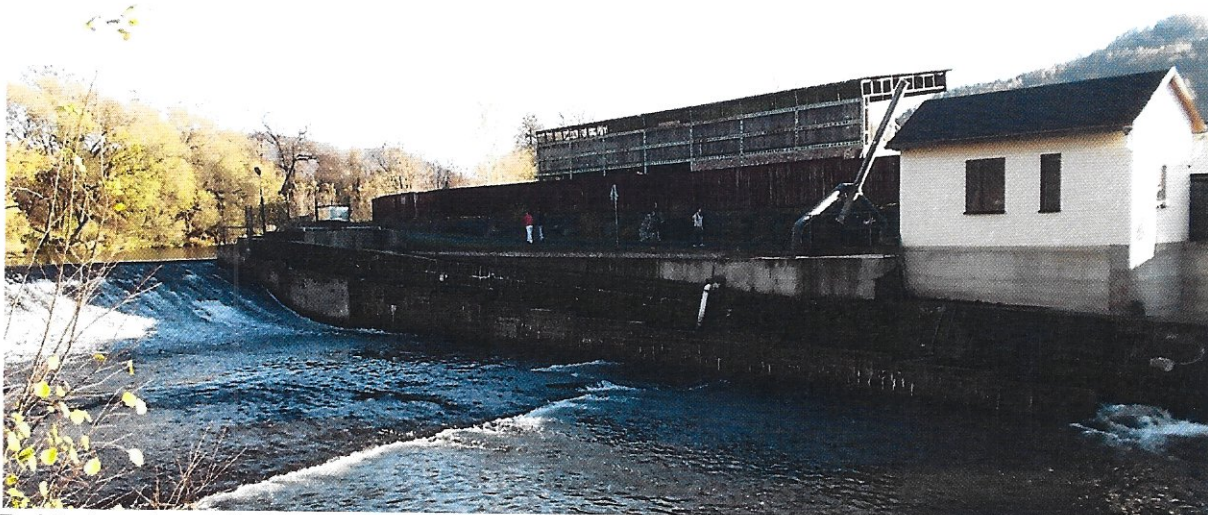
Pohled na levobřežní zavázání jezu s příjezovou MVE
