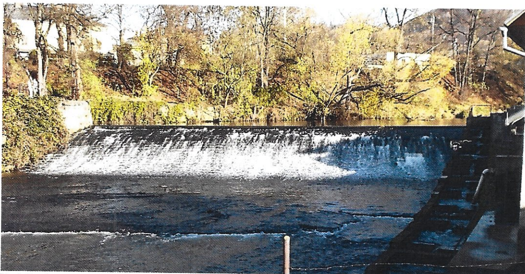
Pohled na vzdouvací těleso jezu (proti vodě z LB)
