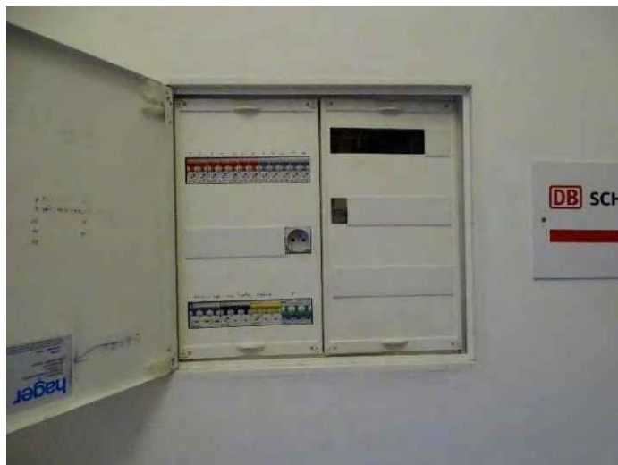
S4 – stávající rozvaděč napájení v 1.NP s jističem přívodu sirény
