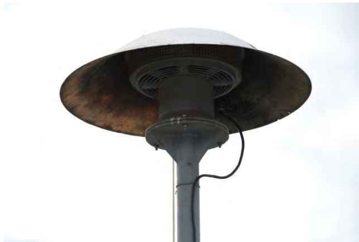
S10 – umístění sirény na přírubě stožáru
