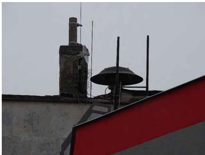
S14 – uchycení sirény na přírubě stožáru
