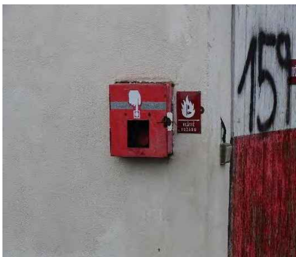
S14 – stávající tlačítko lokálního spuštění
