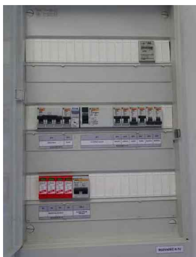
Obr. P1-5 – doplnění rozvaděče R-TU Matra o nový vývod B6 pro napájení převaděče P1
