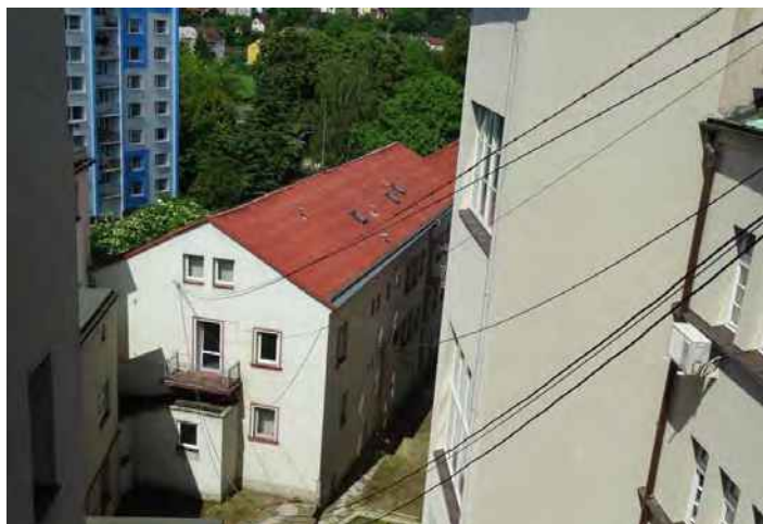
Obr. VP 4 – stávající převěs datové sítě mezi budovami MP a MMD
