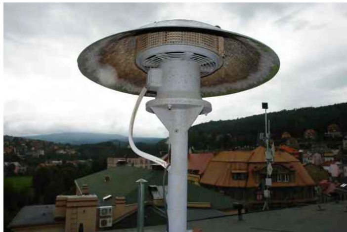
S19 – stávající stožár sirény s přírubou
