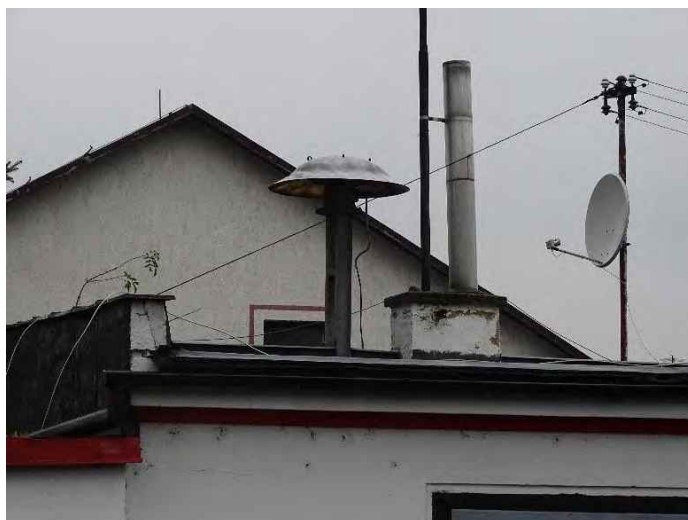
S16 – uchycení sirény na přírubě stožáru
