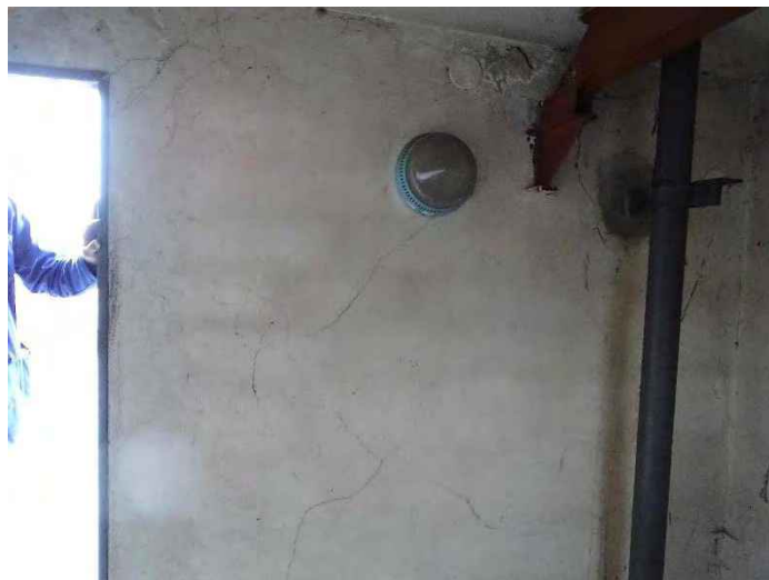
S8 – nový rozvaděč sirény na stěně, nový přívod napájení
