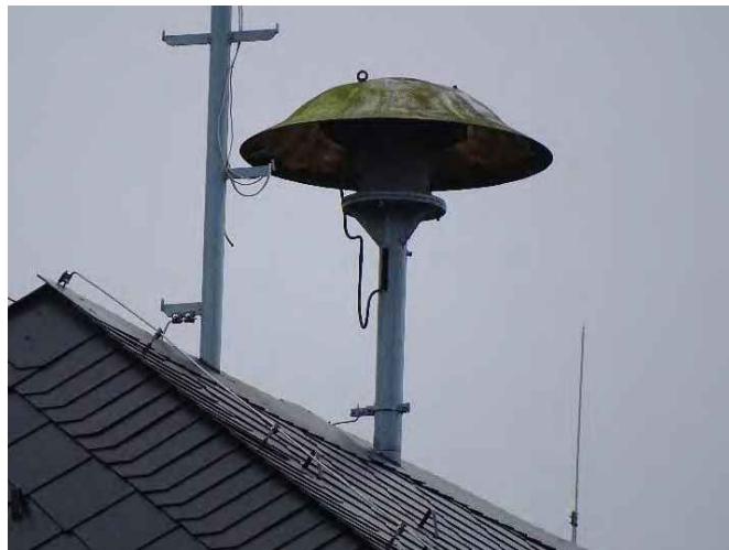
S20– stávající stožár sirény s přírubou
