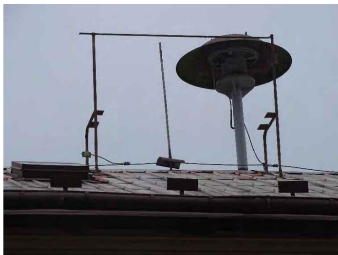
S4 – uchycení sirény na přírubě stožáru
