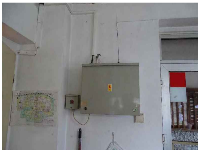
S8 – stávající rozvaděč sirény a tlačítko lokálního spuštění ve vrátnici Sempra a.s.
