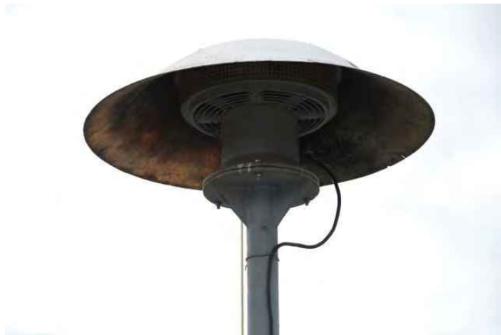
S10 – umístění sirény na přírubě stožáru
