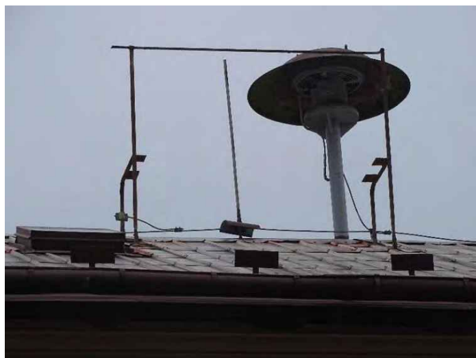
S4 – uchycení sirény na přírubě stožáru
