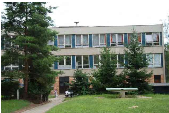
S12 – rotační siréna na budově školy
