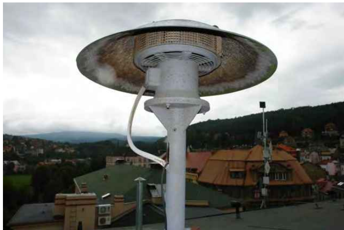
S19 – stávající stožár sirény s přírubou
