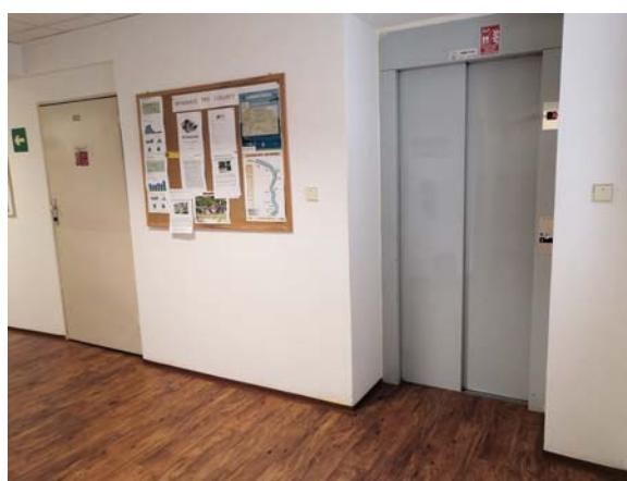
nástupiště v horní stanici místo stávající nástěnky je možné umístit rozvaděč
