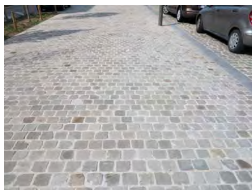
Nový cyklochodník z kosrky s broušenou hranou, Antverpy 2014.
