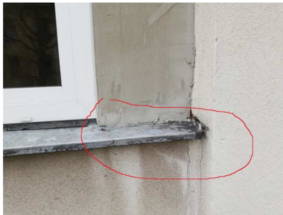
10. Detail zazděného ponechaného oplechování parapetu se zděnou náhradou MIV
