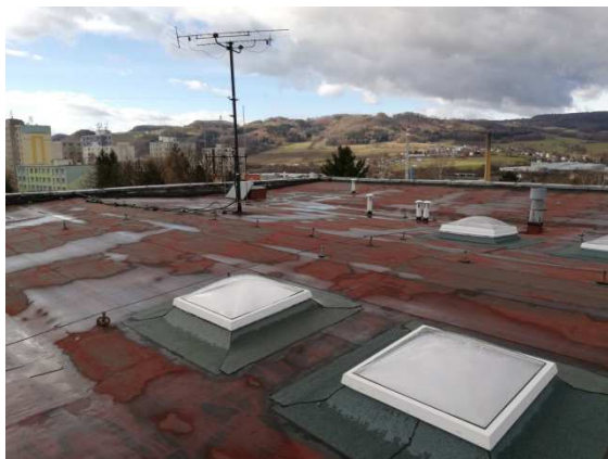
21. Pohled na vyměněné čočkové světlíky
