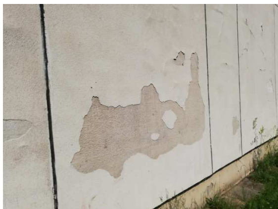
16. Detail opadání vrchní vrstvy omítky
