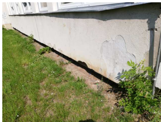
14. Detail poškozených hran parapetních dílců a vrchní vrstvy omítky odpadající v ploše
