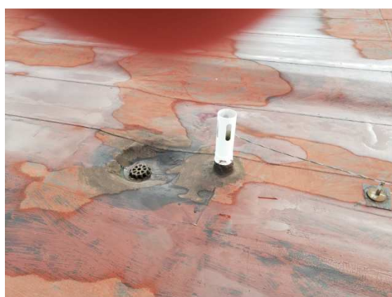
19. Detail střešní vpusti a odvětrávacího komínku kanalizace.
