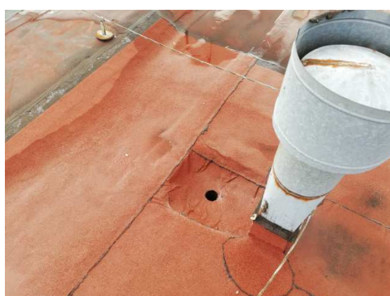
20. Detail střešní vpusti bez ochranného krytu a ventilační hlavice VZT
