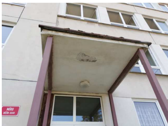
16. Detail markýzy vstupu s narušenou omítkou vlivem zatékání
