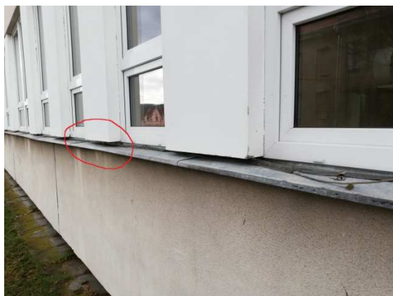
11. Detail osazení nových MIV n západní fasádě
