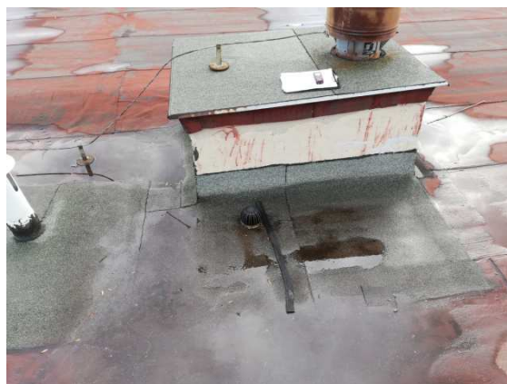
18. Detail nástavby VZT se střešním vtokem
