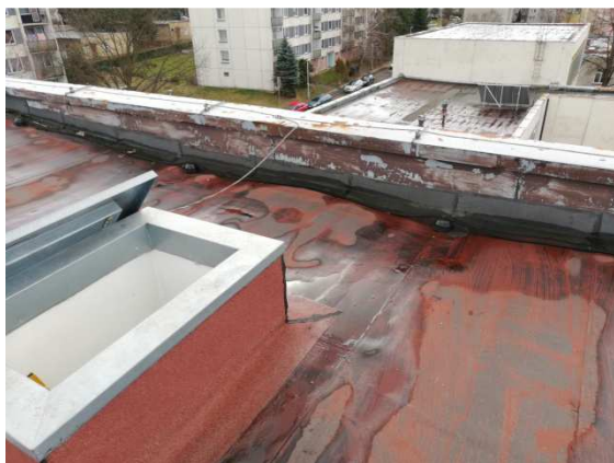
22. Detail střešního výlezu a oplechování atik
