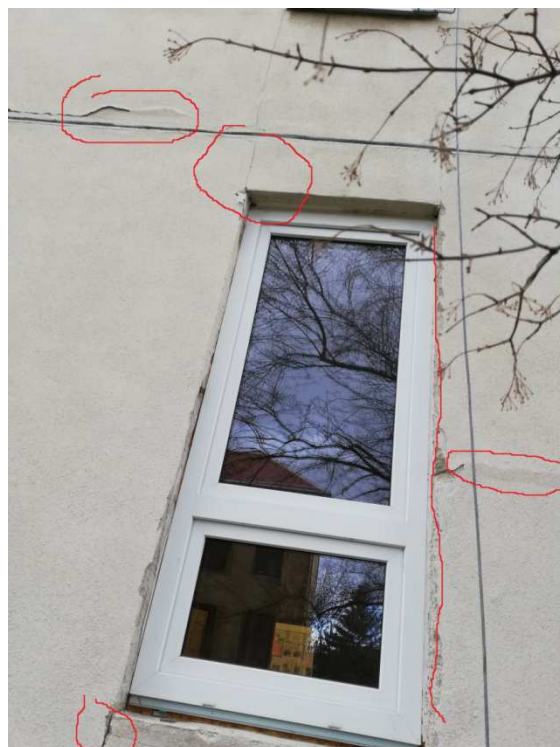
13. Detail trhliny v omítce překladu nad otvorem, přisekání ostění pro osazení okna a nesoudržnosti omítky
