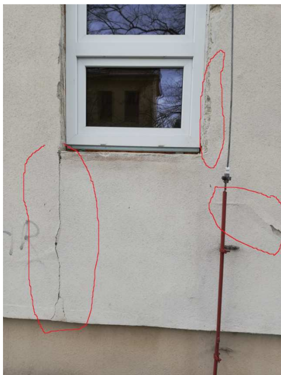
12. Detail osazení okna s trhlinou v omítce na styku parapetního dílce a štitového panelu
