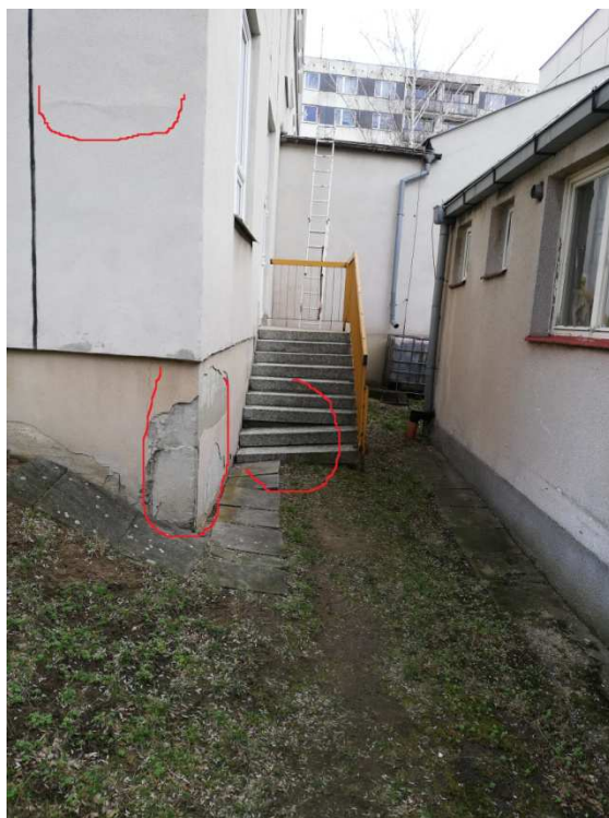
9. Detail stavu omítek soklu jihozápadního nároží a stavu předsazeného schodiště s rozvolněnými stupni a okapovým chodníčkem
