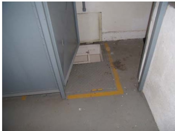
vstup do strojovny po závěs. žebříku poklopem a dveřmi
