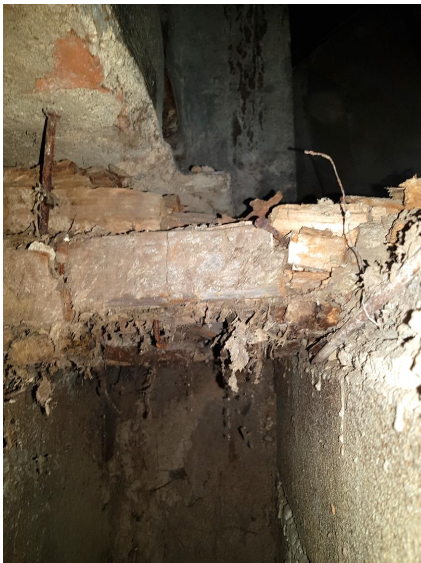
Vlevo: Dutina pod podlahou. Na pohledu záklopu neaktivní rhizomorfy dřevomorky.
