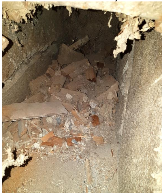
Vlevo: Dutina pod podlahou. Na pohledu záklopu neaktivní rhizomorfy dřevomorky.
