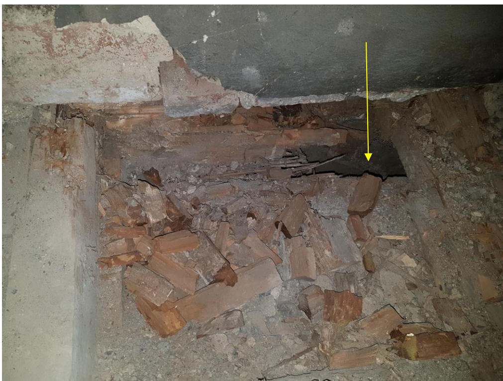
Ložisko napadení po vybrání zásypu. Zbytky věnce s typickým kubickým rozpadem strávené dřevní hmoty. Šipkou označena dutina.
