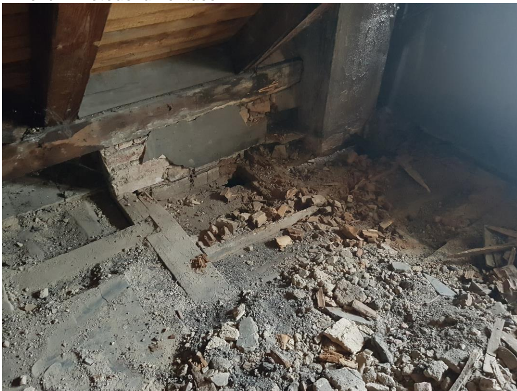
Ložisko napadení na SV nároží. Podlahové trámy.
