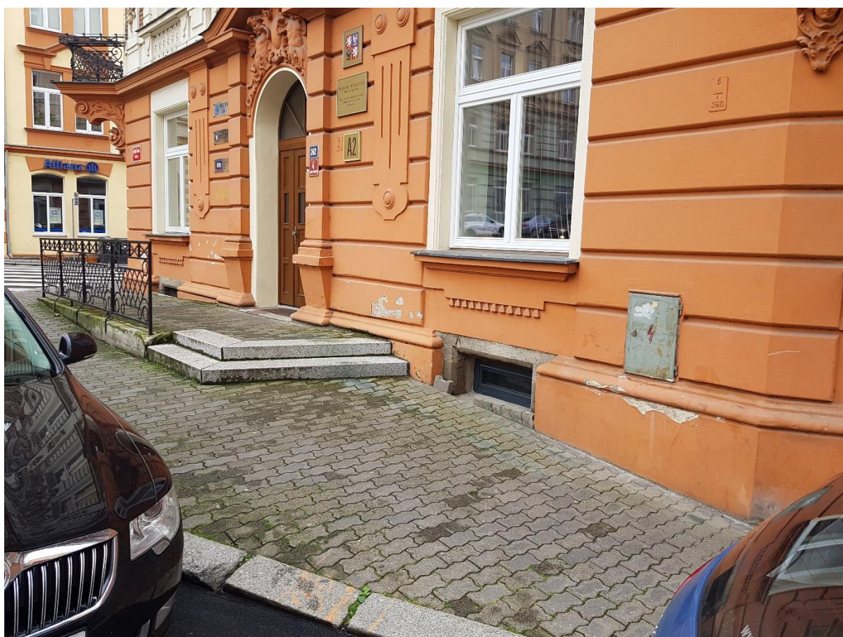
Foto 2: část soklu do Mírového náměstí. Poloha okénka vpravo ukazuje navýšení terénu o 15 až 30 cm, u okénka vlevo je rampa o cca 40 cm nad původním terénem. Skladba chodníku a rampy neobsahuje funkční svislou hydroizolaci. Původní vstupní schodiště bylo v úrovni pod rampou. Nutno rozebrat pás chodníku i rampy, zaizolovat a vrátit.
