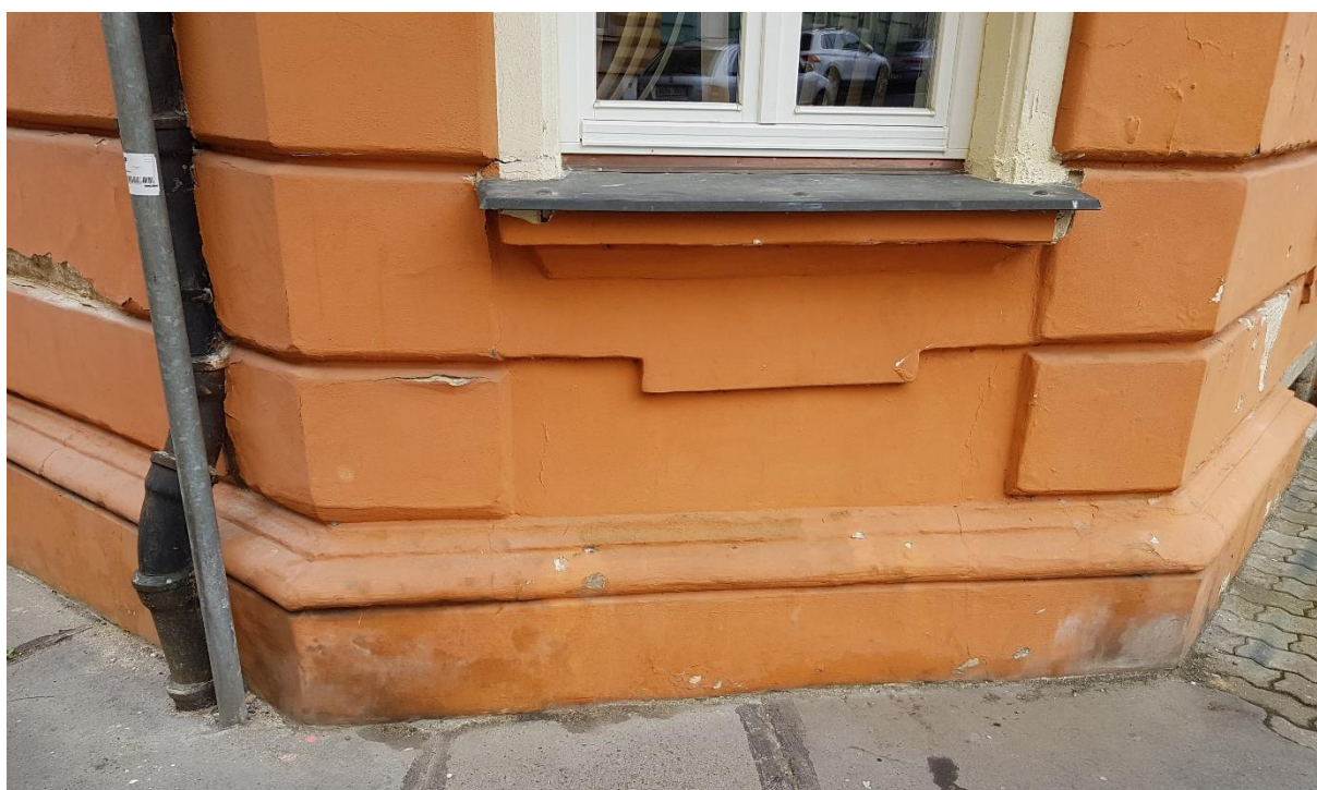
Foto 7: nároží Mírové náměstí / Ruská. Omítky poškozené vztlínáním vlhkosti. Úplná výměna skladby omítek, 20% plochy
