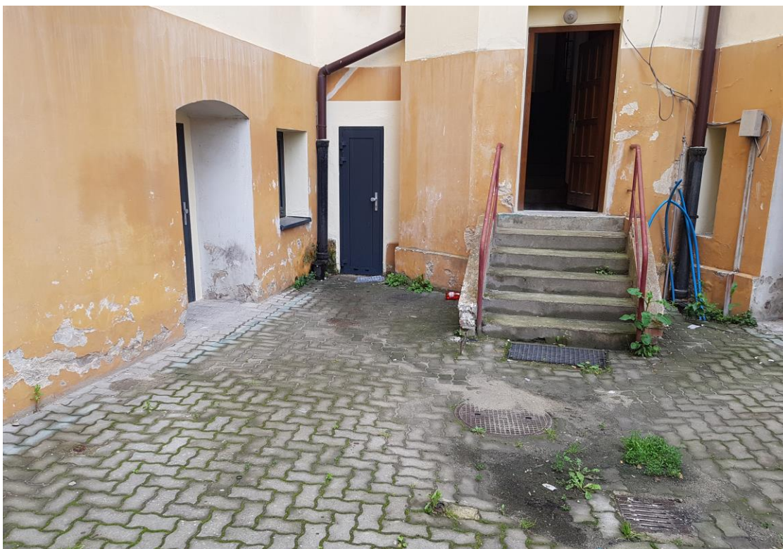
Foto 15: centrální část do Mírového náměstí, jižní průčelí s východem do dvora. I zde předpokládáno navýšení min. 10 cm oproti původní situaci. Chybějící sokly na průčelí vlevo (jihovýchodní průčelí křídla do Jungmannovy)
