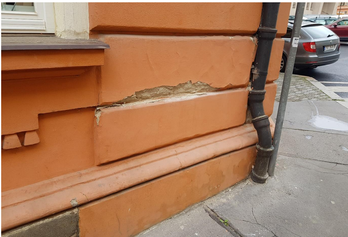
Foto 7: Parter v ulici Ruské, konec u Mírového nám. Omítky poškozené vzlínáním vlhkosti. Úplná výměna skladby omítek, 20% plochy. Sokl pokračuje min 20 cm pod chodníkem.
