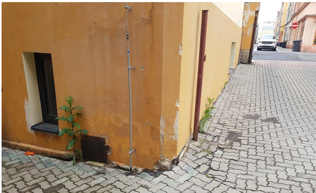
Foto 13: Dvorní fasáda JZ nároží křídla podél Ruské. Horní hrana soklu mizí pod terénem, na jižní fasádě sokl zcela od terénem.
