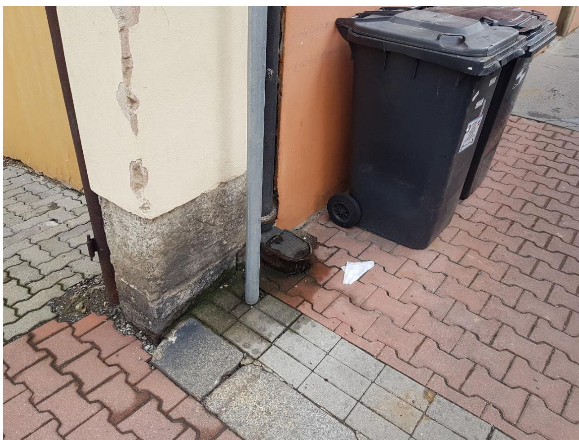
Foto 10: Patrné kamenné zdivo spodní stavby. Obrubník mezi chodníkem (+0,2 m) a vjezdem do dvora (navýšen o dalších 10 cm).
