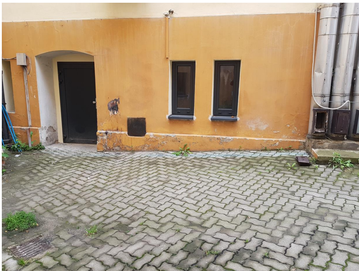
Foto 14: Dvorní fasáda, západní průčelí křídla do Ruské. Vstup byl původně nejméně jedním schodem nahoru (proti zatékání deště). Patrné odvodnění dvora vpravo.
