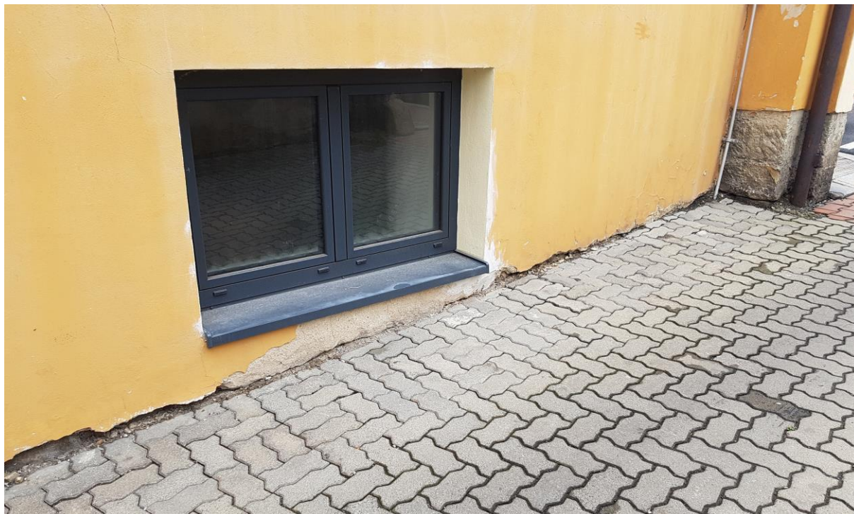
Foto 11: Dvorní fasáda od jihu při vjezdu z Ruské ulice. Navýšení terénu cca 30 cm, celá výška soklu pod chodníkem. Cihelné zdivo v kontaktu s vodou pod dlažbou.
