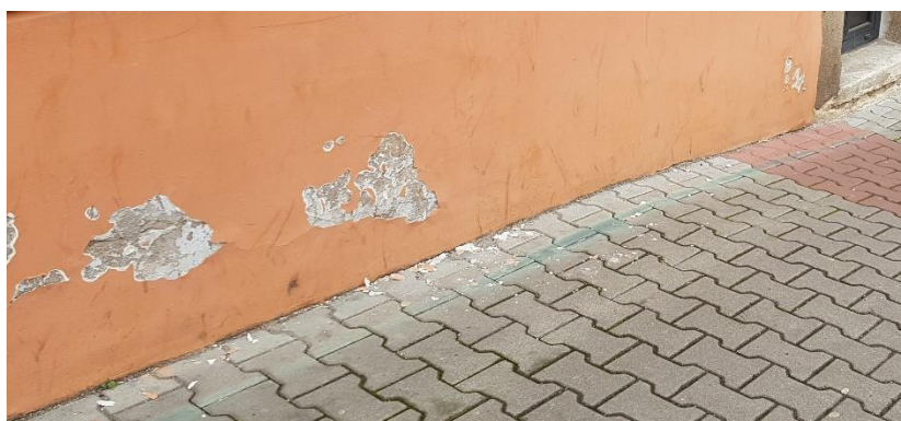
Foto 3, 4: fasáda parteru z ulice Jungmannovy. Patrné poškození nátěru a štukové vrstvy na 20% soklu. Poloha okének ukazuje navýšení terénu o cca 10-15 cm.
