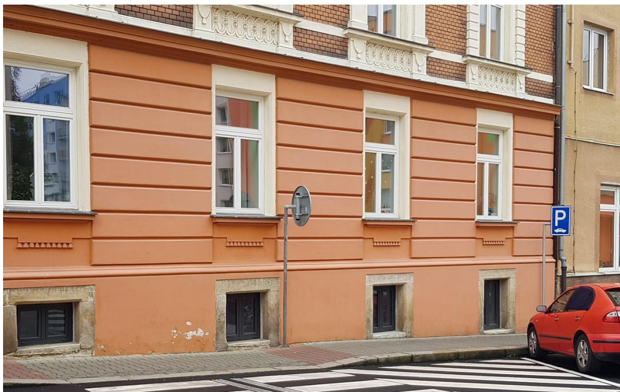
Foto 3, 4: fasáda parteru z ulice Jungmannovy. Patrné poškození nátěru a štukové vrstvy na 20% soklu. Poloha okének ukazuje navýšení terénu o cca 10-15 cm.
