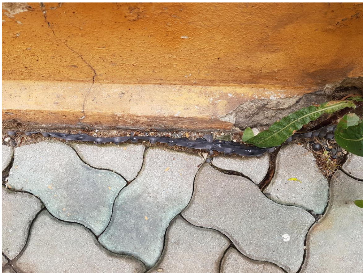
Foto 12: Dvorní fasáda, JZ roh křídla do Ruské. Pokus o izolaci dlažby od soklu zdiva pomocí nopové folie, nefunkční, voda zatéká za folii. Detail celku z foto 13.
