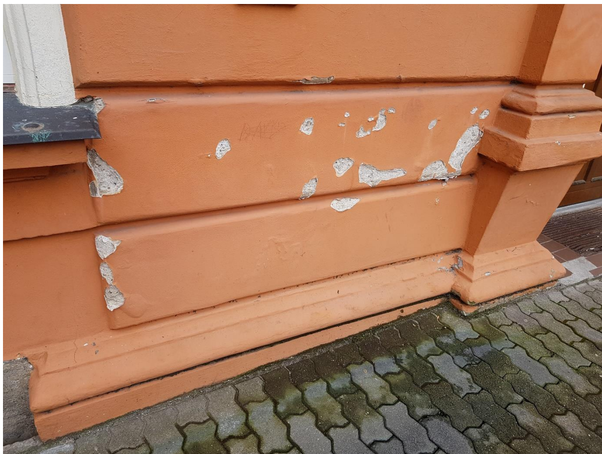
Foto 6: Omítky zdiva nad soklem, levá část rampy z Mírového náměstí. Poškození parteru 20% plochy, úplná výměna omítek za vysoušecí
