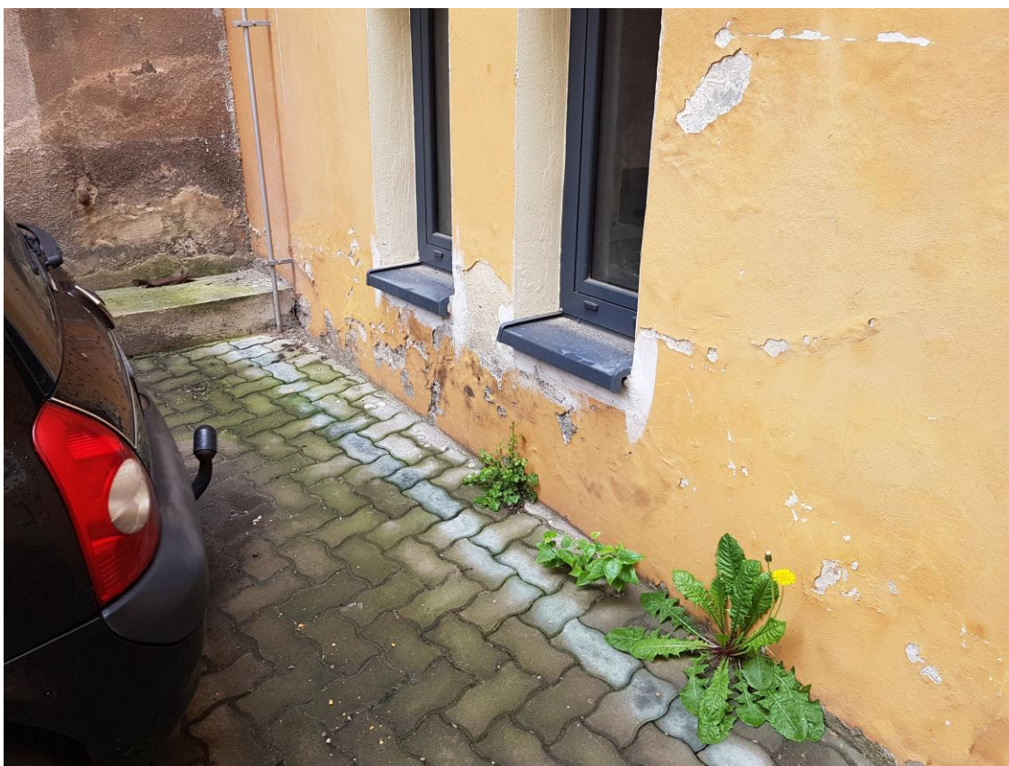
Foto 16: jihovýchodní průčelí křídla do Jungmannovy, zeď objektu 640/3. Navýšení terénu cca 30 cm patrné i na soklu sousedního objektu.
