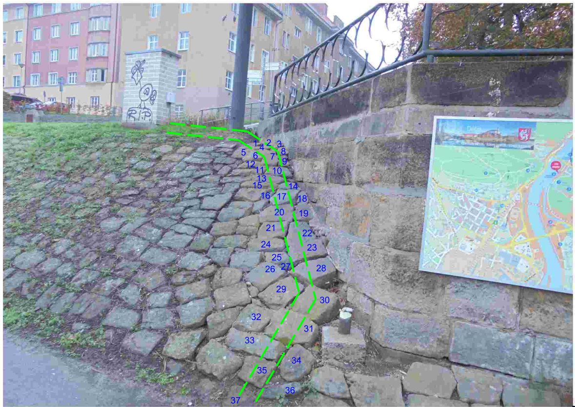
kameny budou označeny dle čísel a po stavbě stejně poskládány kabel vést pod kameny
