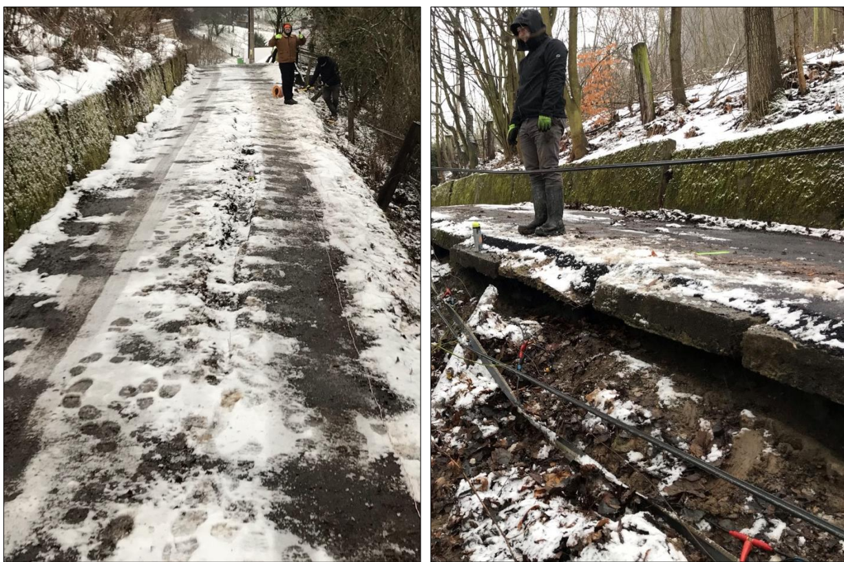
obr. 2. Poškození komunikace v severní části území: posunutí panelů a vznik trhliny uprostřed vozovky (vlevo), dutiny v podloží východního okraje vozovky (vpravo)
