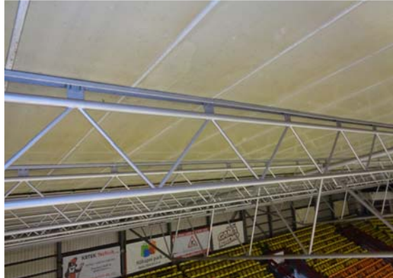
obr. č. 1: krokvička ve středové části je rovnoběžná s příhradovou vaznicí
