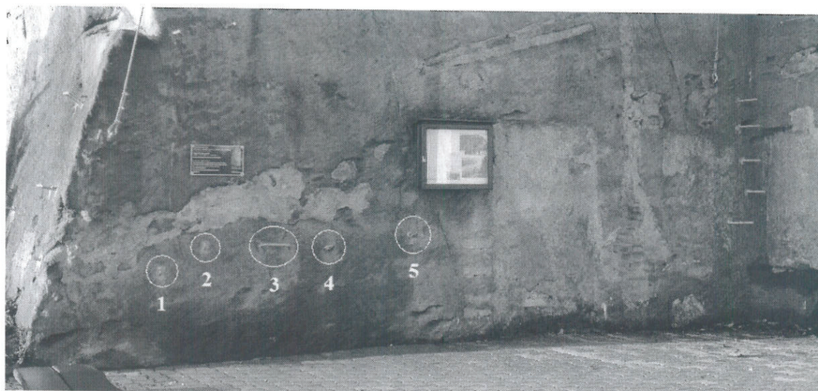
Obr. 5: Zkušební kotvy a oka u nástupního místa
