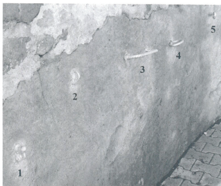
Obr. 6: Zkušební kotvy a oka u nástupního místa
