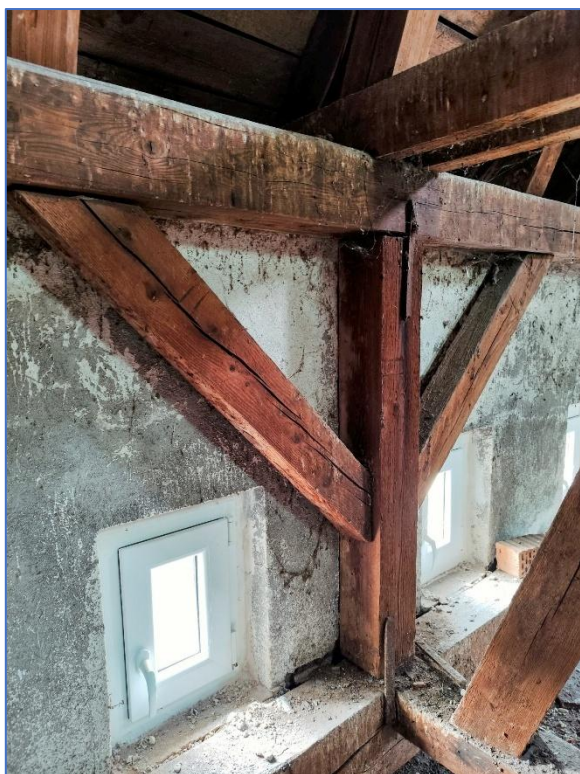
OBR.Č. 26 – 27 – PRAVÁ VĚŽ – DŘ. KCE JSOU SILNĚ ZNEČIŠTĚNY HOLUBÍM TRUSEM CELKOVĚ INDEX B
