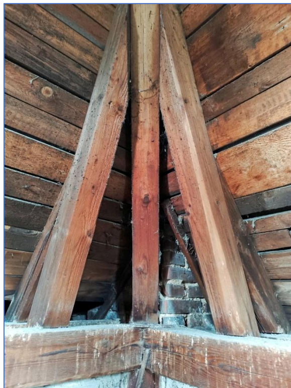
OBR.Č. 28 - 29 - PRAVÁ VĚŽ - DŘ. KCE JSOU SILNĚ ZNEČIŠTĚNY HOLUBÍM TRUSEM CELKOVĚ INDEX B
