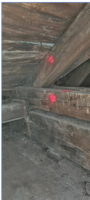
OBR.Č. 38 – 39 – 40 – KRITICKÁ MÍSTA HLAVNÍHO PŮDNÍHO PROSTORU – ULOŽENÍ VAZNÍCH TRÁMŮ DO ZDIVA /ZHLAVÍ – INDEX D
