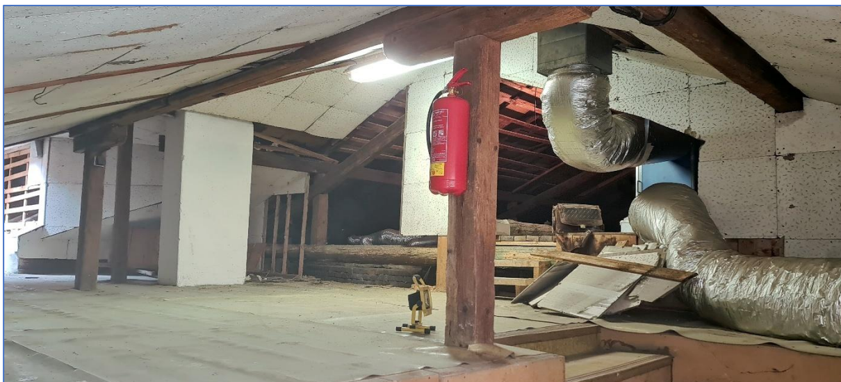
OBR.Č. 3 – POHLED DO BOČNÍHO PŮDNÍHO PROSTORU OD VCHODOVÉHO SCHODIŠTĚ
