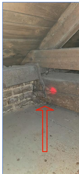
OBR.Č. 35 – 36 – 37 – KRITICKÁ MÍSTA HLAVNÍHO PŮDNÍHO PROSTORU – ULOŽENÍ VAZNÍCH TRÁMŮ DO ZDIVA /ZHLAVÍ – INDEX D - ODBĚR VZORKU VZ2 (OBR.Č.36)
