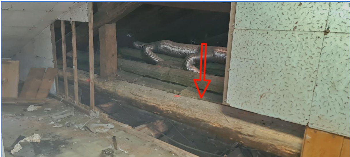
OBR.Č. 10 – BIOTICKÁ DESTRUKCE STROPNÍHO TRÁMU AKTIVNÍMI LARVAMI DŘ. HMYZU – TESAŘÍKOVITÍ – INDEX C - D
