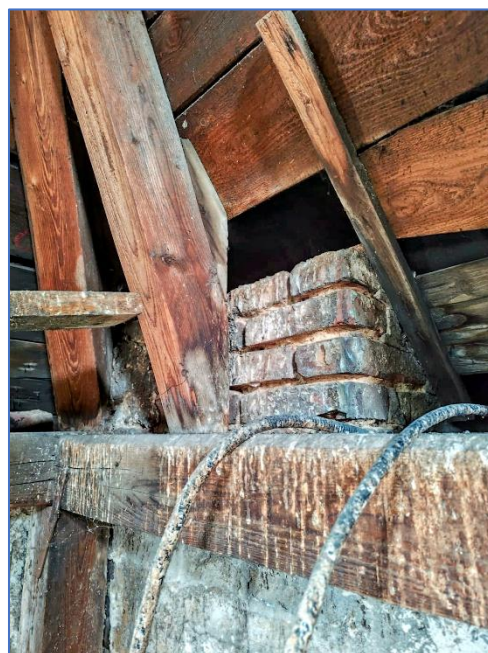
OBR.Č. 20 – 21 – LEVÁ VĚŽ – DŘ. KCE JSOU SILNĚ ZNEČIŠTĚNY HOLUBÍM TRUSEM CELKOVĚ INDEX B
