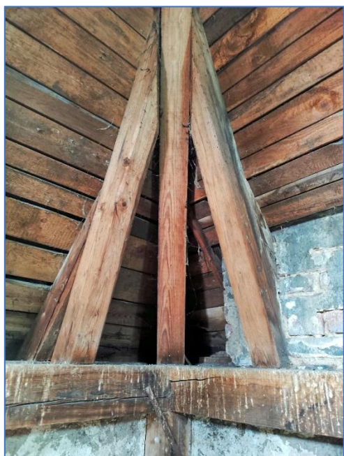
OBR.Č. 20 – 21 – LEVÁ VĚŽ – DŘ. KCE JSOU SILNĚ ZNEČIŠTĚNY HOLUBÍM TRUSEM CELKOVĚ INDEX B
