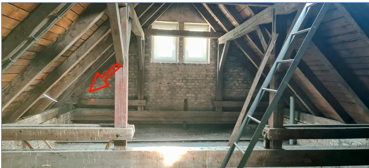
OBR.Č. 32 – ZADNÍ LEVÁ POZICE (VYVÝŠENÁ ČÁST) – BIOTICKÁ DESTRUKCE KONSTR. SPOJE KROKEV – KLEŠTINA – INDEX D
