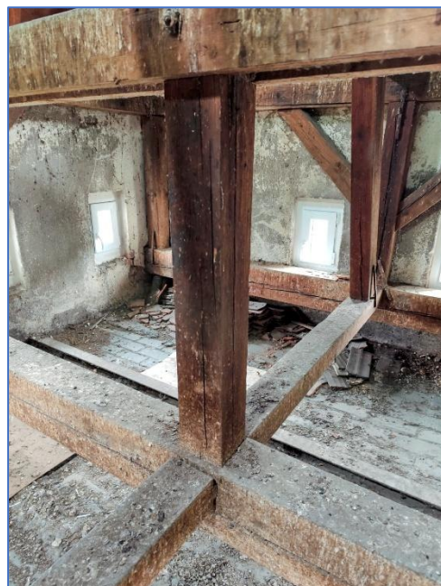
OBR.Č. 22 – 23 – LEVÁ VĚŽ – DŘ. KCE JSOU SILNĚ ZNEČIŠTĚNY HOLUBÍM TRUSEM CELKOVĚ INDEX B
