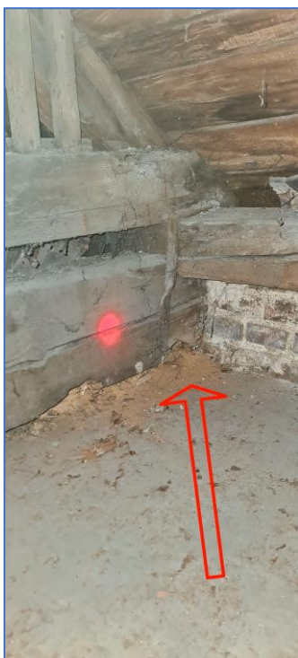
OBR.Č. 35 – 36 – 37 – KRITICKÁ MÍSTA HLAVNÍHO PŮDNÍHO PROSTORU – ULOŽENÍ VAZNÍCH TRÁMŮ DO ZDIVA /ZHLAVÍ – INDEX D - ODBĚR VZORKU VZ2 (OBR.Č.36)
