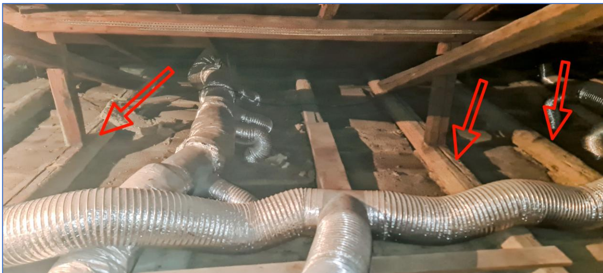
OBR.Č. 16 - BIOTICKÁ DESTRUKCE STROPNÍCH TRÁMŮ AKTIVNÍMI LARVAMI DŘ. HMYZU - TESAŘÍKOVITÍ - INDEX C - D
