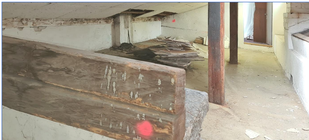
OBR.Č. 7 - LOKÁLNÍ POVRCHOVÁ DESTRUKCE DŘ. KCÍ AKTIVNÍMI LARVAMI DŘ. HMYZU - TESAŘÍKOVITÍ - INDEX C
