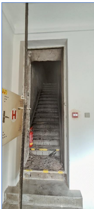
OBR.Č. 30 - VSTUP DO HLAVNÍHO PŮDNÍHO PROSTORU (NAD SÁLEM)
