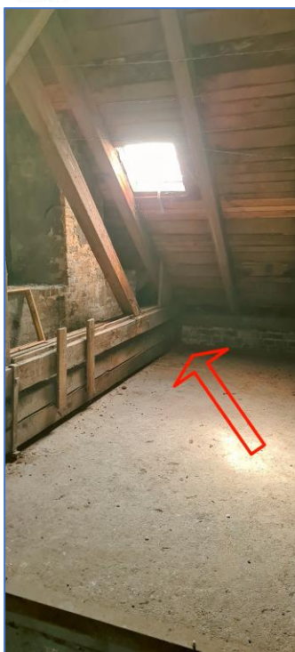
OBR.Č. 35 – 36 – 37 – KRITICKÁ MÍSTA HLAVNÍHO PŮDNÍHO PROSTORU – ULOŽENÍ VAZNÍCH TRÁMŮ DO ZDIVA /ZHLAVÍ – INDEX D - ODBĚR VZORKU VZ2 (OBR.Č.36)
