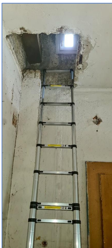
OBR.Č. 19 - VSTUP DO LEVÉ (ČELNĚ K OBJEKTU) VĚŽE
