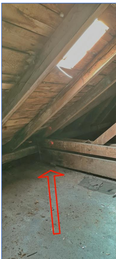
OBR.Č. 38 – 39 – 40 – KRITICKÁ MÍSTA HLAVNÍHO PŮDNÍHO PROSTORU – ULOŽENÍ VAZNÍCH TRÁMŮ DO ZDIVA /ZHLAVÍ – INDEX D
