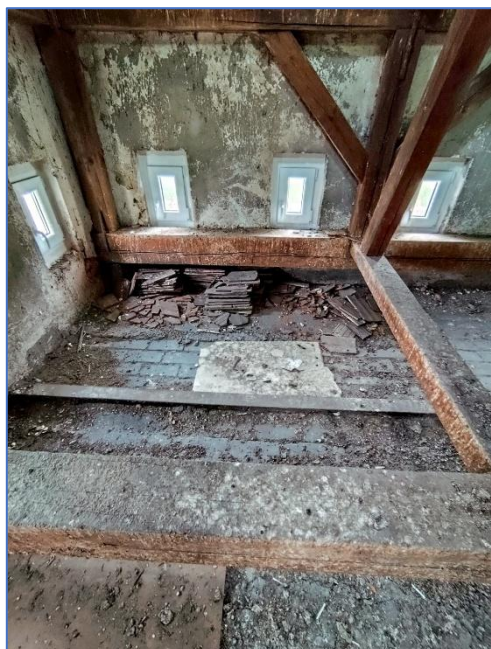
OBR.Č. 22 – 23 – LEVÁ VĚŽ – DŘ. KCE JSOU SILNĚ ZNEČIŠTĚNY HOLUBÍM TRUSEM CELKOVĚ INDEX B
