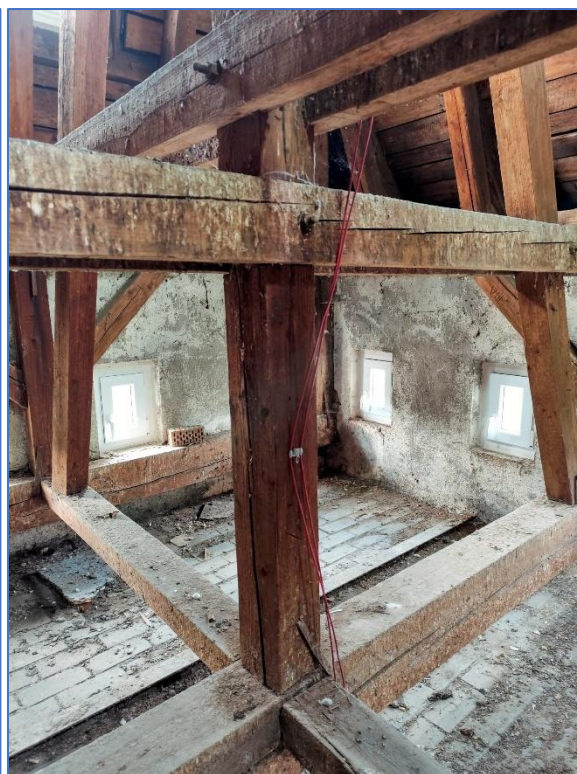
OBR.Č. 26 – 27 – PRAVÁ VĚŽ – DŘ. KCE JSOU SILNĚ ZNEČIŠTĚNY HOLUBÍM TRUSEM CELKOVĚ INDEX B
