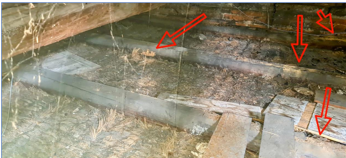
OBR.Č. 12 - BIOTICKÁ DESTRUKCE STROPNÍCH TRÁMŮ AKTIVNÍMI LARVAMI DŘ. HMYZU - TESAŘÍKOVITÍ - INDEX C - D - ODBĚR VZORKU VZ3
