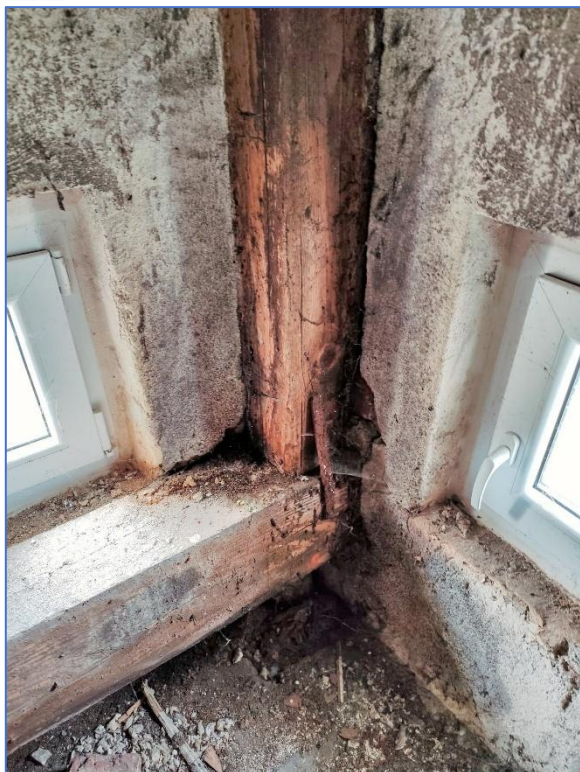
OBR.Č. 28 - 29 - PRAVÁ VĚŽ - DŘ. KCE JSOU SILNĚ ZNEČIŠTĚNY HOLUBÍM TRUSEM CELKOVĚ INDEX B
