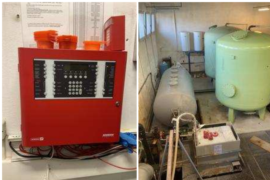
Obrázek 13 - ústředna EPS + jedna z úprav vody
