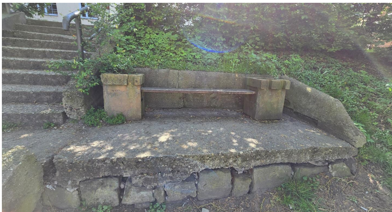
Obrázek 6: Betonová plocha s lavičkou v úrovni podesty schodiště
