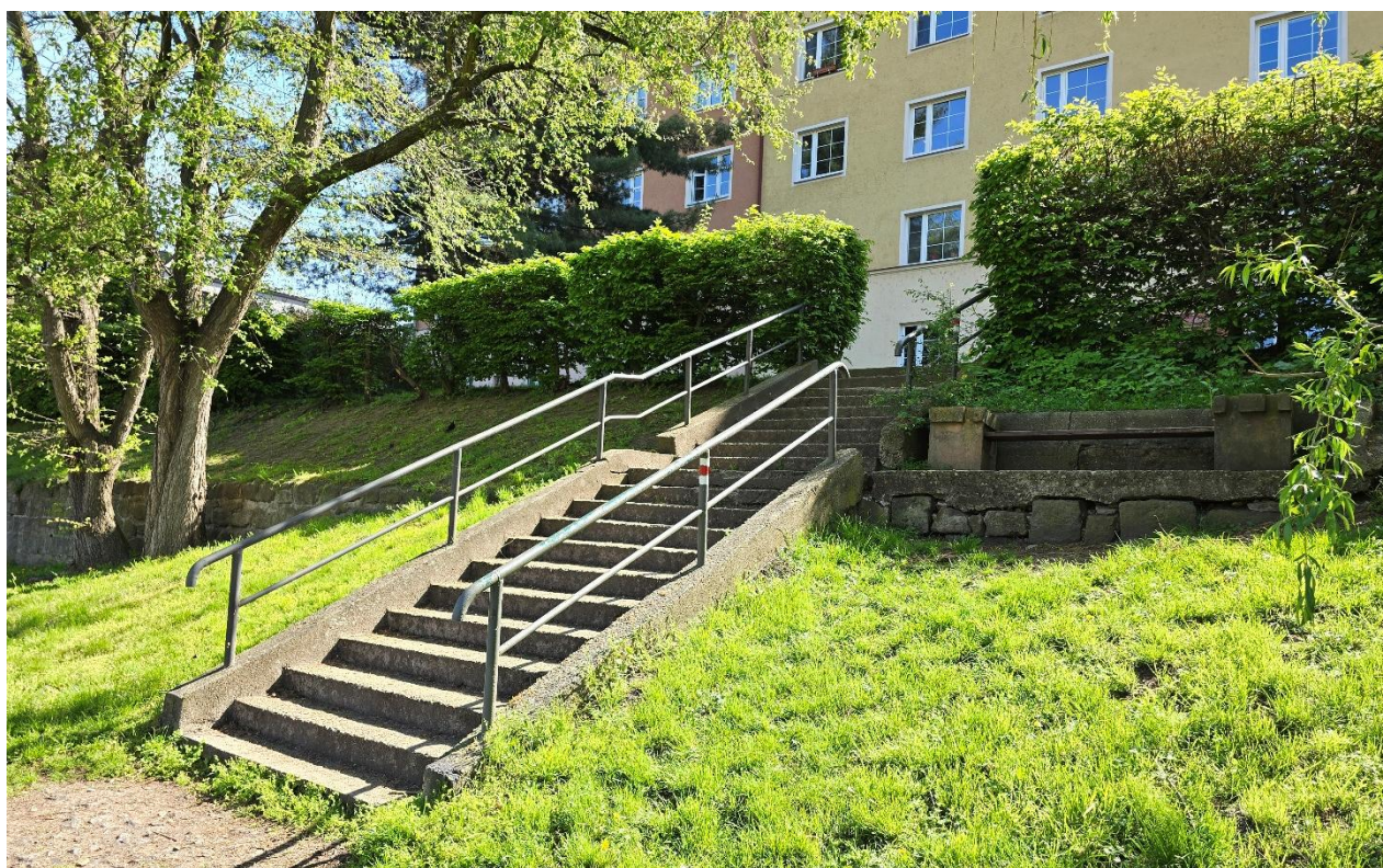
Obrázek 6: Schodiště s bočními zídkami a podestou a betonovou plochou s lavičkou
