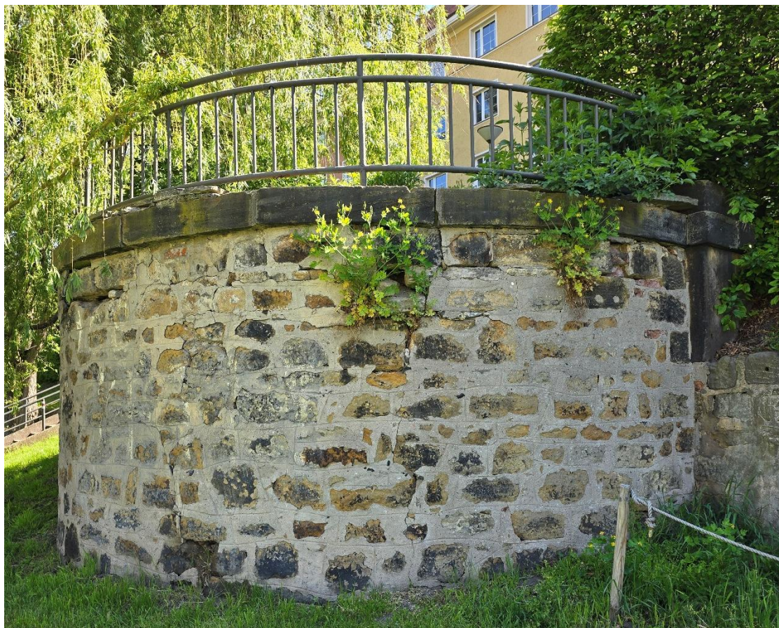
Obrázek 1: Pohled zprava na opěrnou zeď
