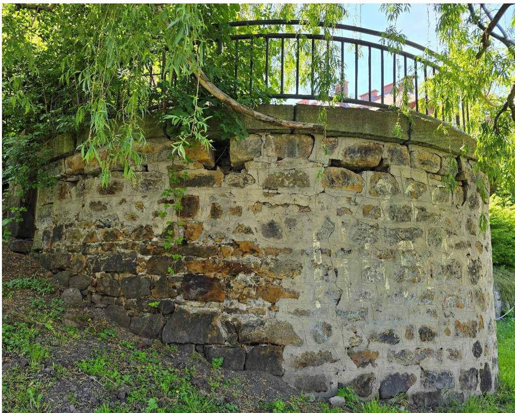
Obrázek 3: Pohled zleva na opěrnou zeď
