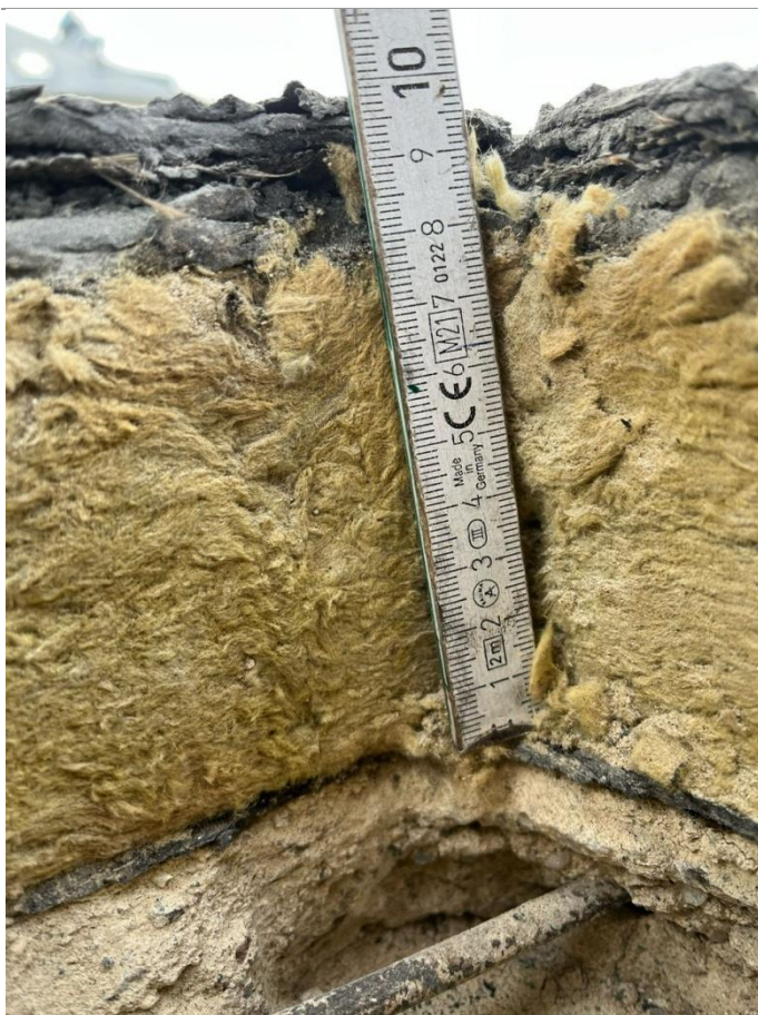
Obrázek 5: Fotodokumentace sondy do střešního pláště objektu tělocvičny, vrchní část skladby s tepelnou izolací z minerální vaty tl. 80 mm
