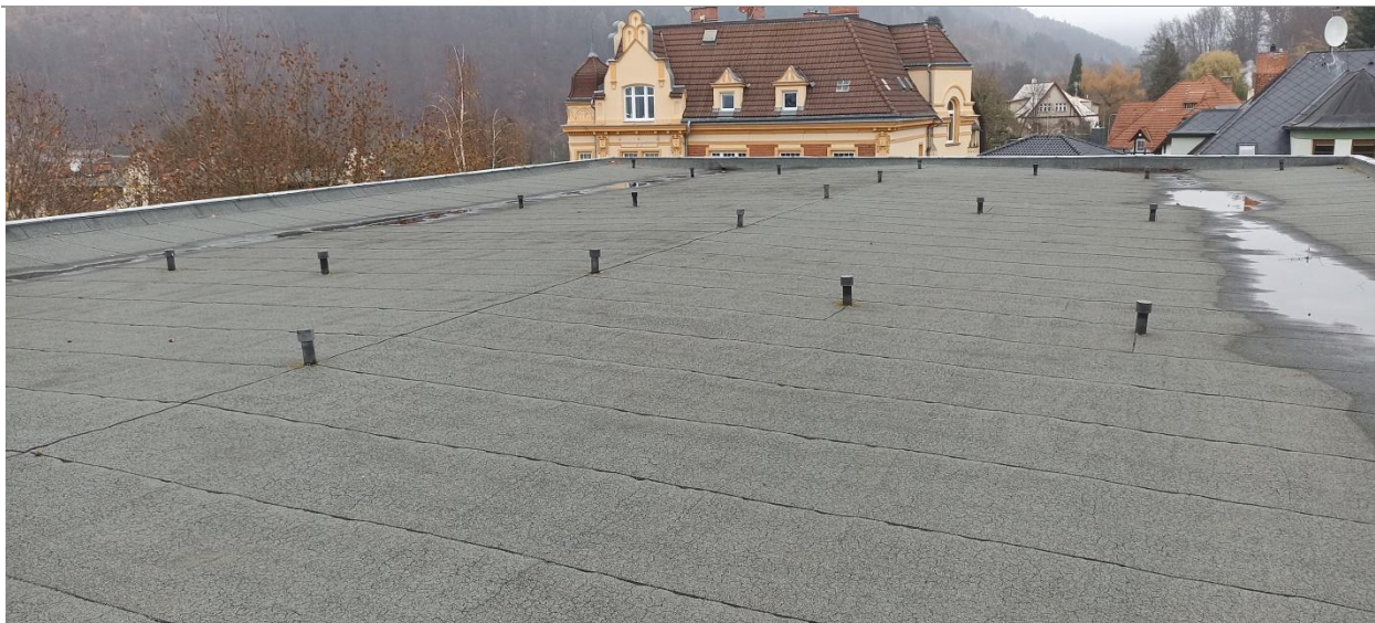
Obrázek 1: Stávající střecha objektu tělocvičny, severní pohled směrem od staré budovy základní školy Dr. Miroslava Tyrše
