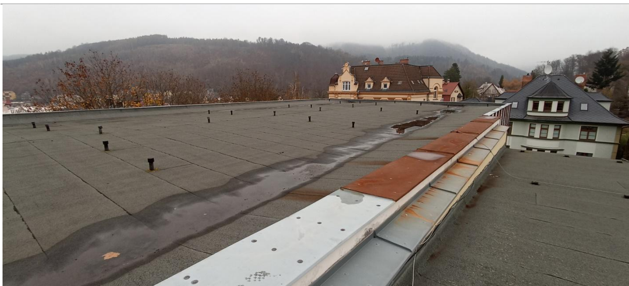
Obrázek 4: Stávající střecha objektu tělocvičny, severozápadní pohled na návaznost střechy přístavby tělocvičny k objektu tělocvičny
