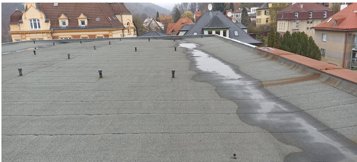
Obrázek 2: Stávající střecha objektu tělocvičny, severovýchodní pohled směrem od staré budovy základní školy Dr. Miroslava Tyrše
