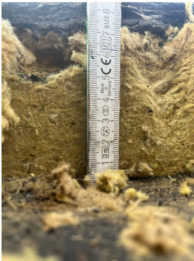
Obrázek 7: Fotodokumentace sondy do střešního pláště objektu tělocvičny, vrchní část skladby s tepelnou izolací z minerální vaty tl. 80 mm, pod tepelnou izolací z minerální vaty je provedena parozábrana z asfaltového pásu
