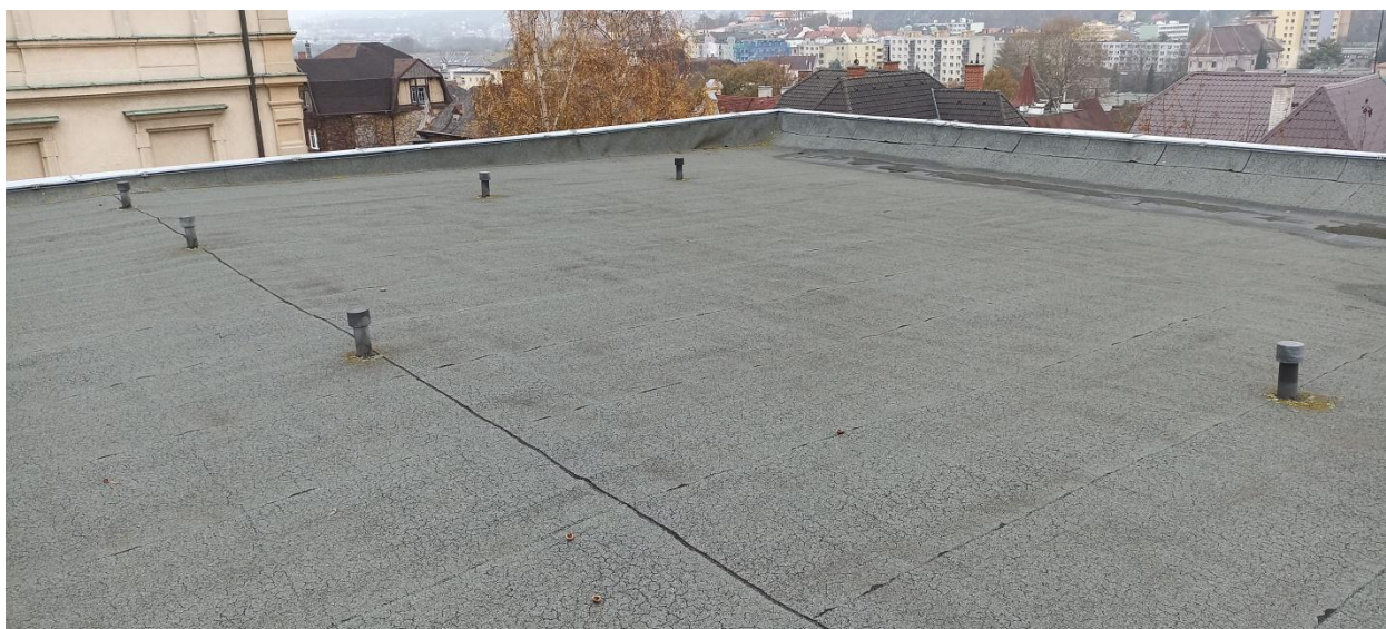
Obrázek 3: Stávající střecha objektu tělocvičny, jihozápadní pohled směrem ke staré budově základní školy Dr. Miroslava Tyrše
