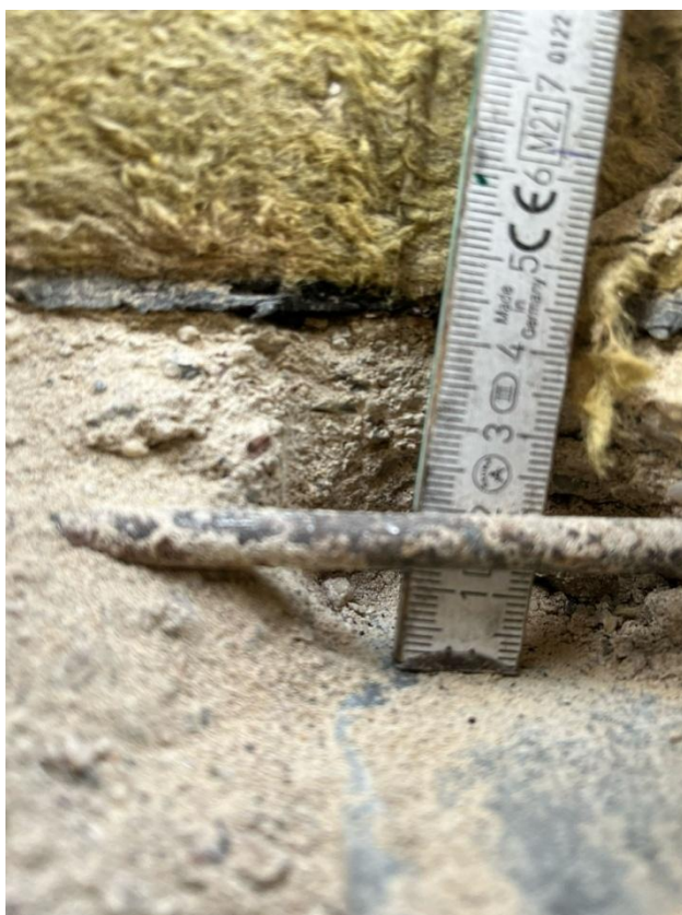
Obrázek 6: Fotodokumentace sondy do střešního pláště objektu tělocvičny, spodní část skladby s betonovou mazaninou tl. 50 mm nad horní částí trapézového plechu
