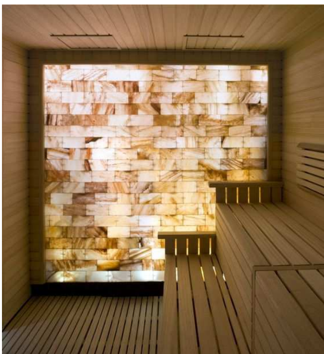
Podsvícené solné bloky na boční stěně
