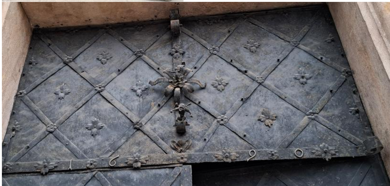
Celoplošné jemné očištní od rzi a celoplošný nátěr matnou kovářskou černí.
