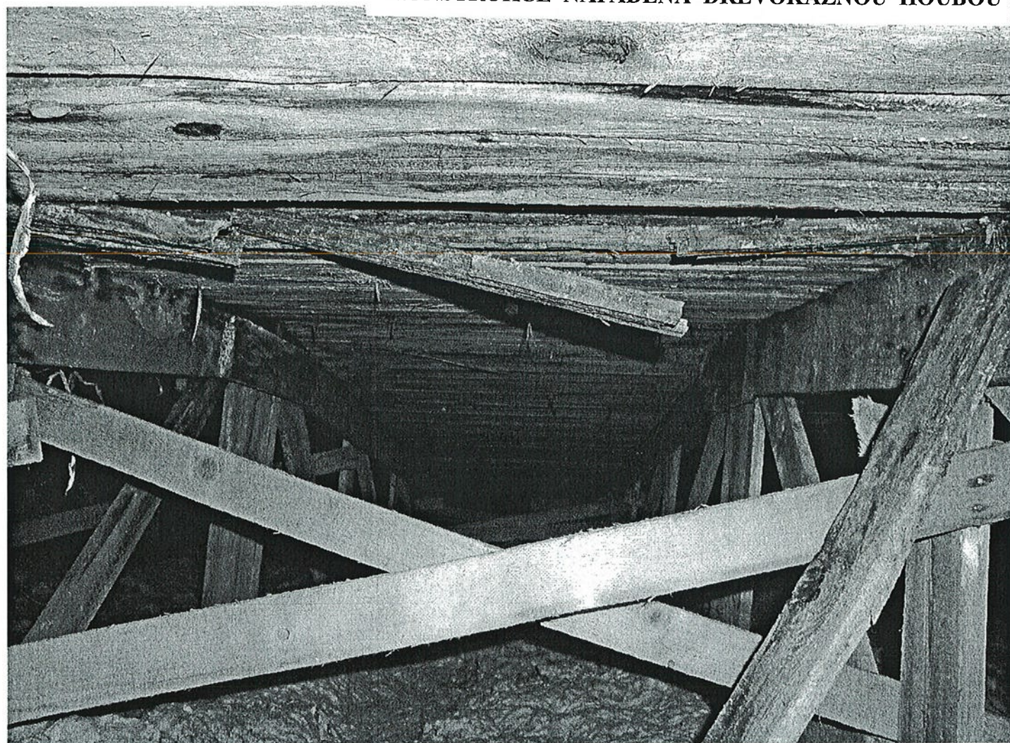
KONSTRUKCE NAPADENÁ DŘEVOKAZNOU HOUBOU
