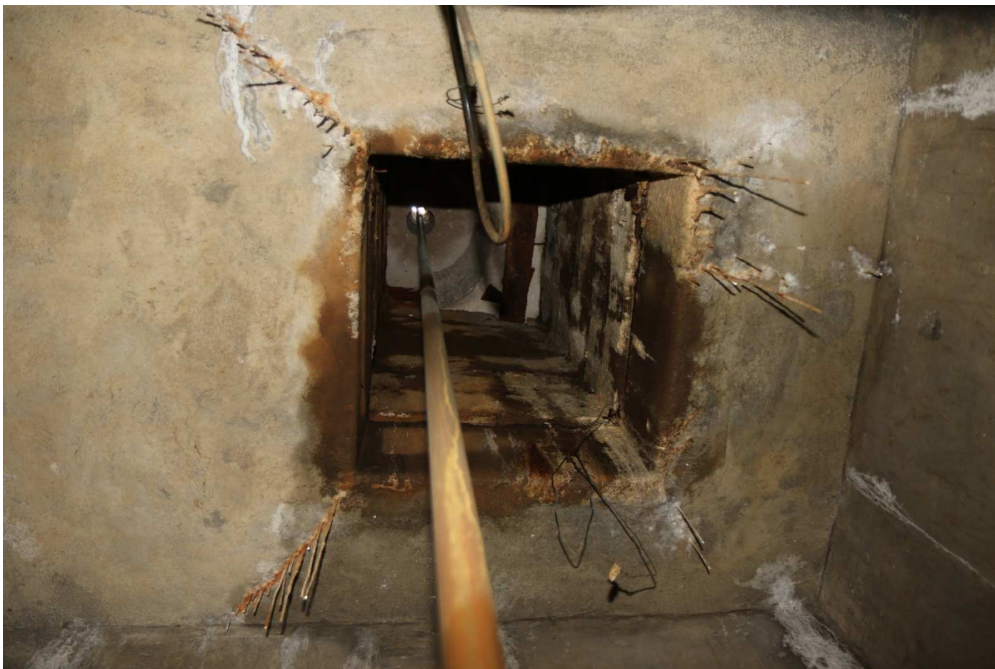
Vnitřek spodní šachty, pohled vzhůru do dřívku sloupu
