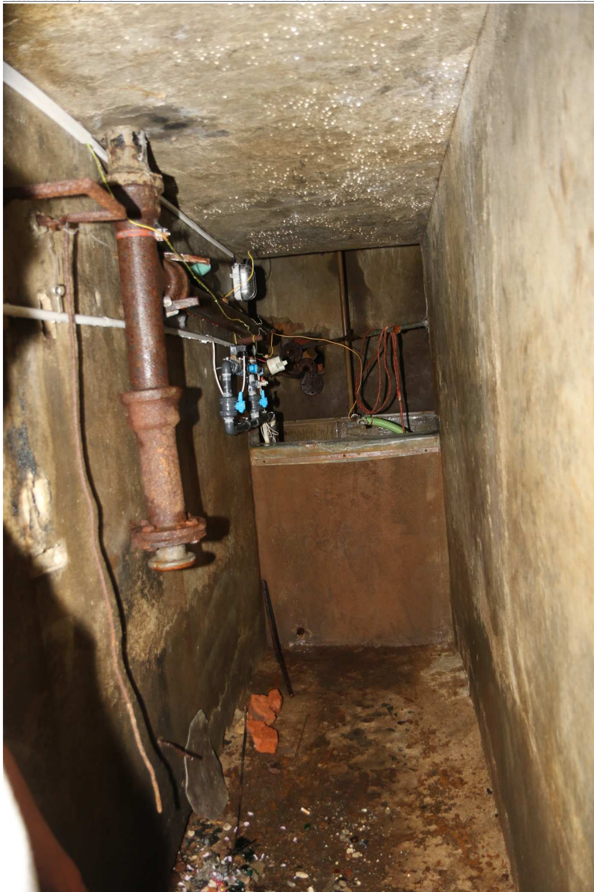
Vnitřek spodní šachty, pohled od žebříku
