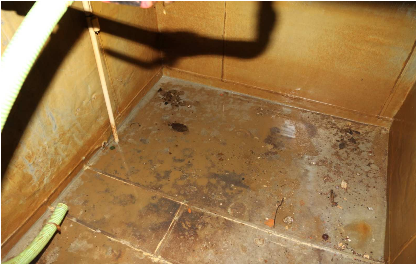
Vnitřek spodní šachty, pohled do nádrže, vyložené olovem
