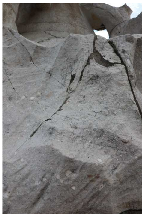
Popraskaný kámen působením bronzových čepů
