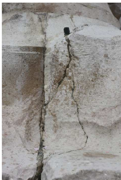
Popraskaný kámen působením bronzových čepů
