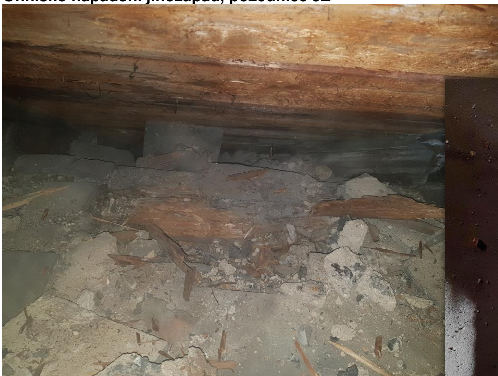
Ohnisko napadení jihozápad, pozednice JZ
