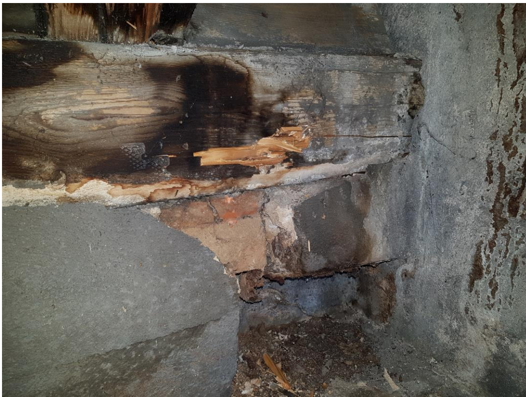
Ohnisko napadení jihovýchod, pozednice SV2 vlevo od komína
