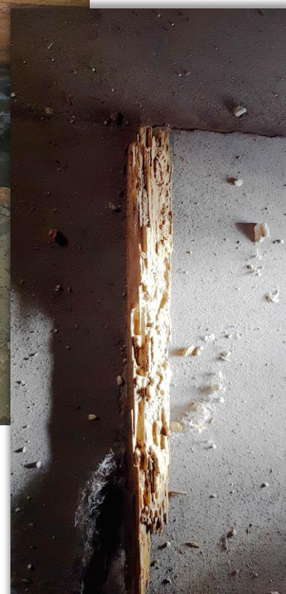
Detail části dřeva z pozednice. Napadení červotočem, Celková ztráta pevnosti prvku. Krokve nedotčeny.
