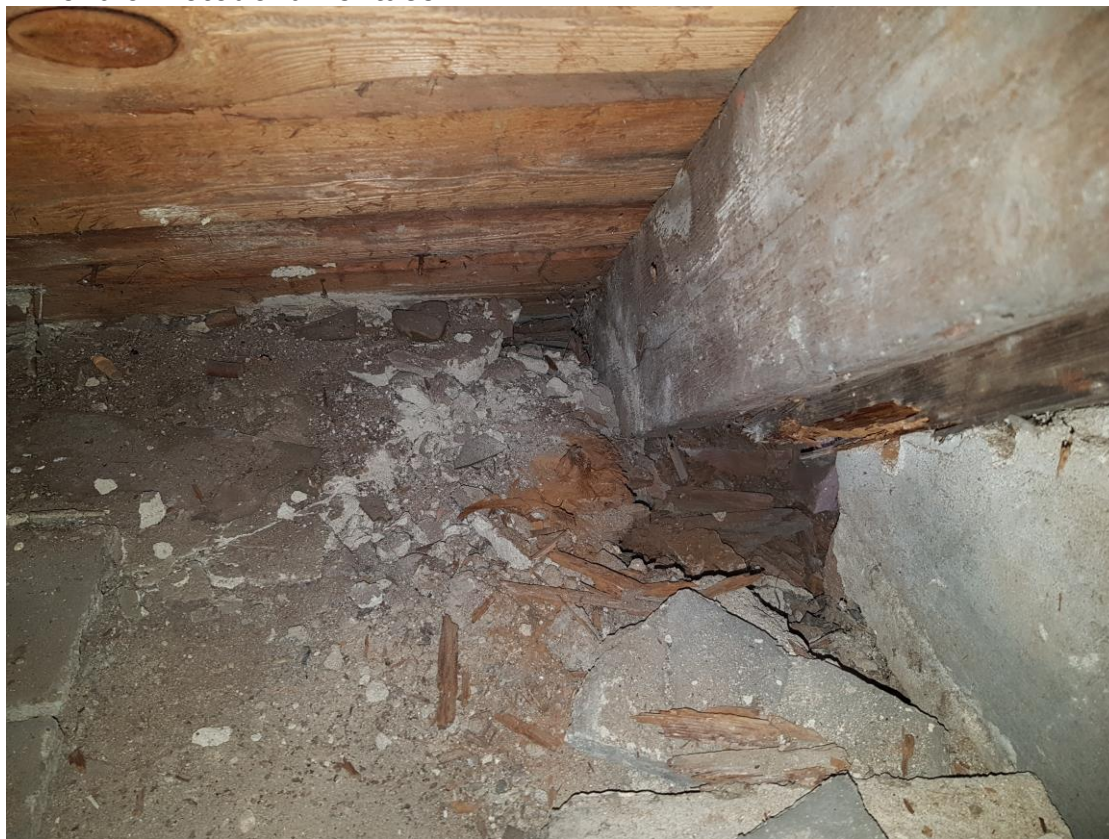
Ohnisko napadení severozápad. Napadená krokev, pod ní napadená pozednice
