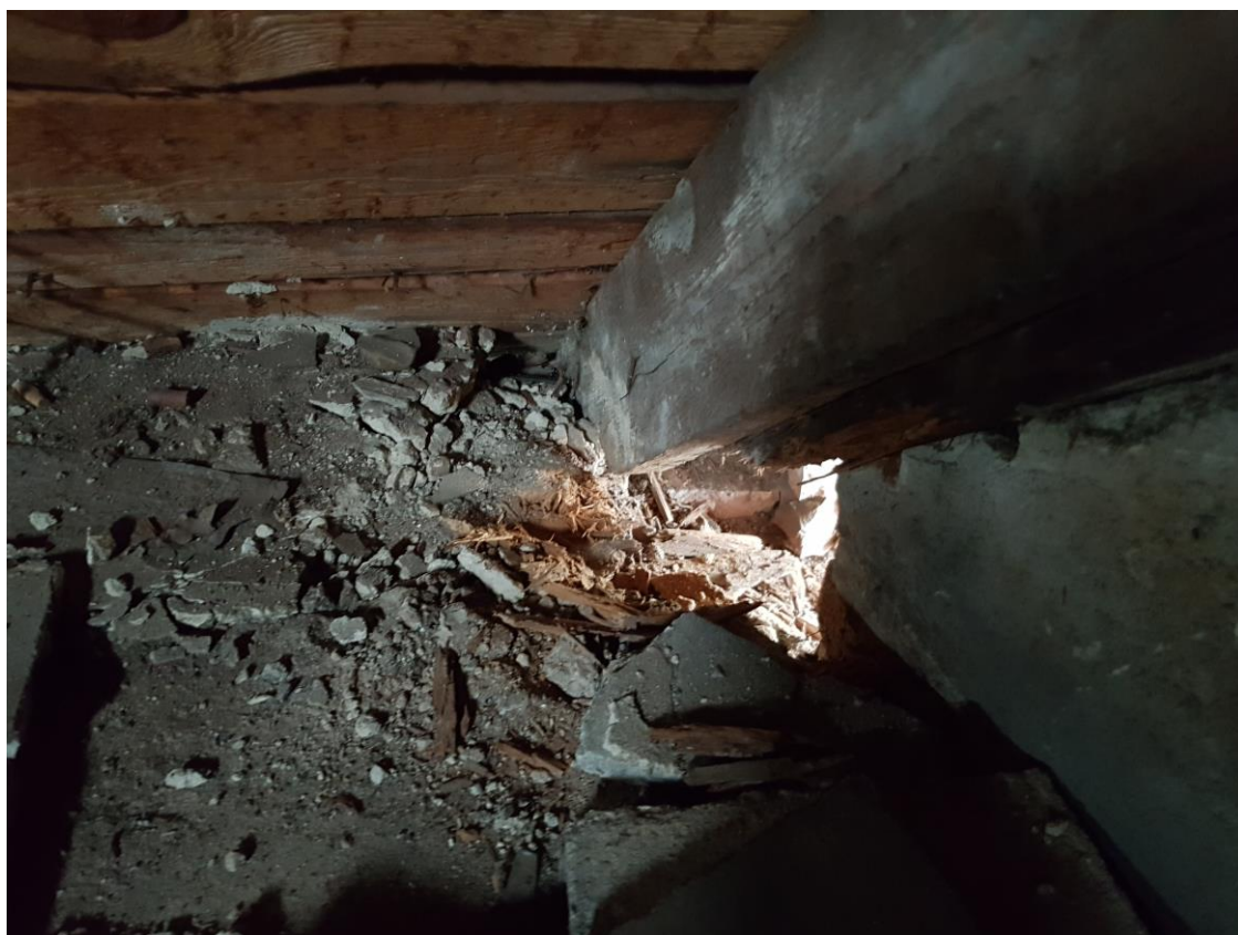
Ohnisko napadení severozápad. Napadená krokev, pod ní napadená pozednice
