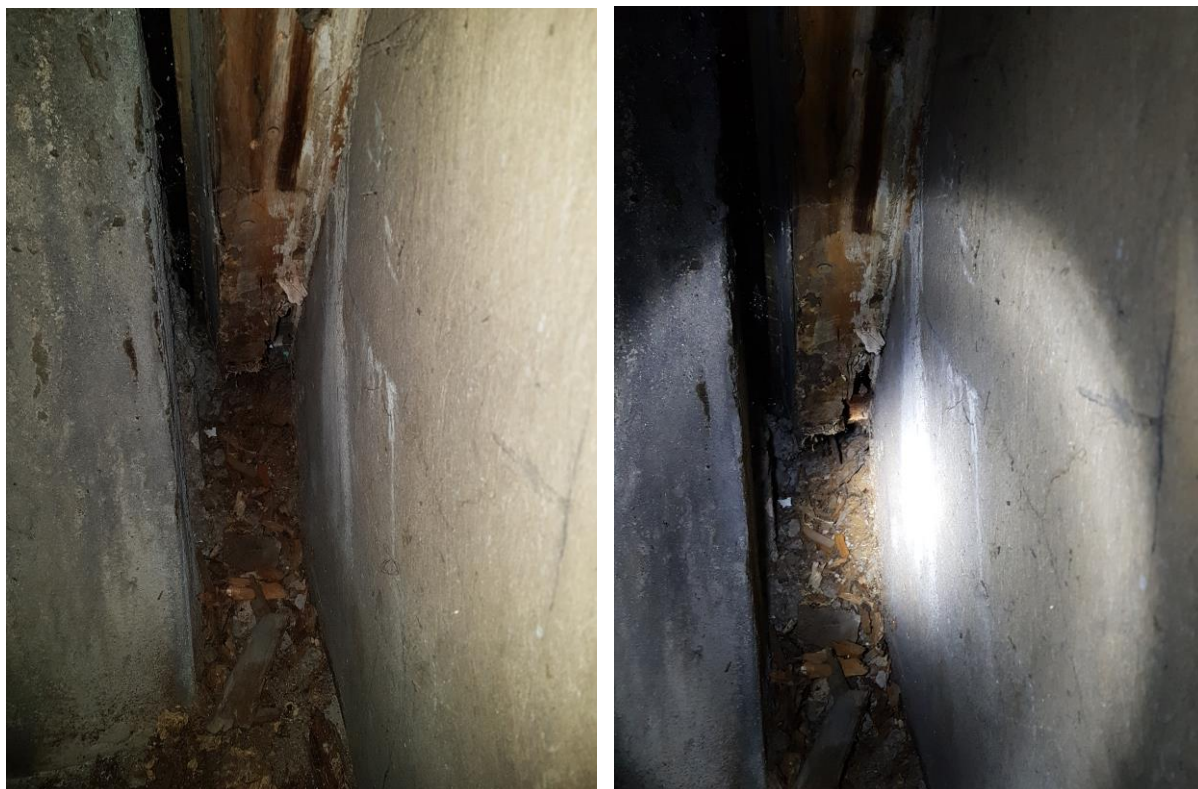
Ohnisko napadení jihovýchod, krokv V1 a pozednice SV1
