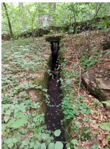
Pohled po toku na propustek pod cestou – vyvalená zed' na levém břehu
