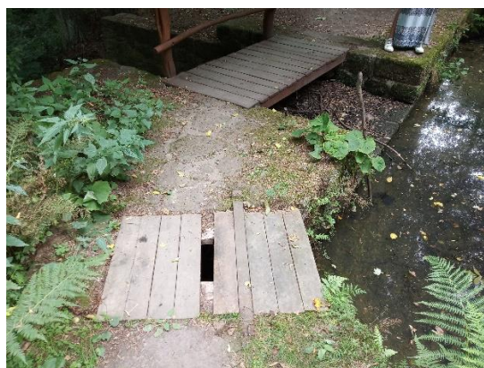
Pohled na poklop požeráku a bezpečnostní přeliv
