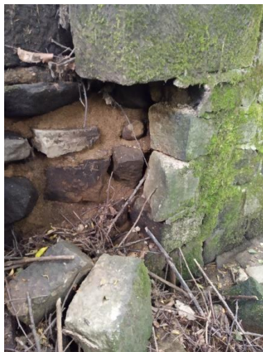
Detail rozpadlého zdiva u bezpečnostního přelivu
