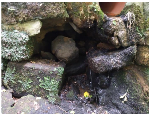
Kaverna pod odpadním potrubím
