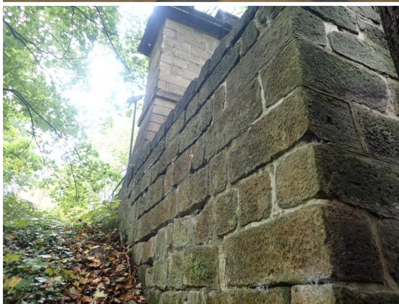
Pohled na vtok levobřežní opěry, resp. křídla – zdivo lehce vybouleno a bez spárování
