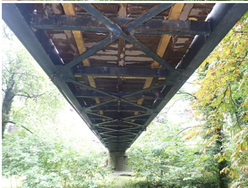
Podhled dřevěné mostovky s doplněnými podélníky
