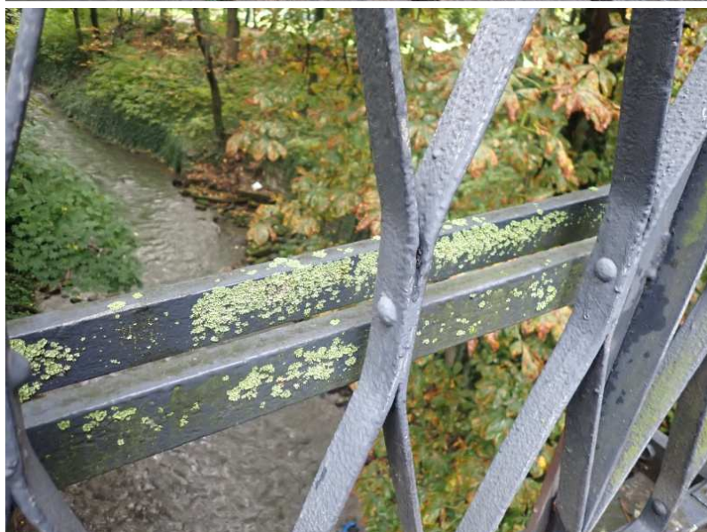
Ocelová táhla lokálně pokryta lišejníky
