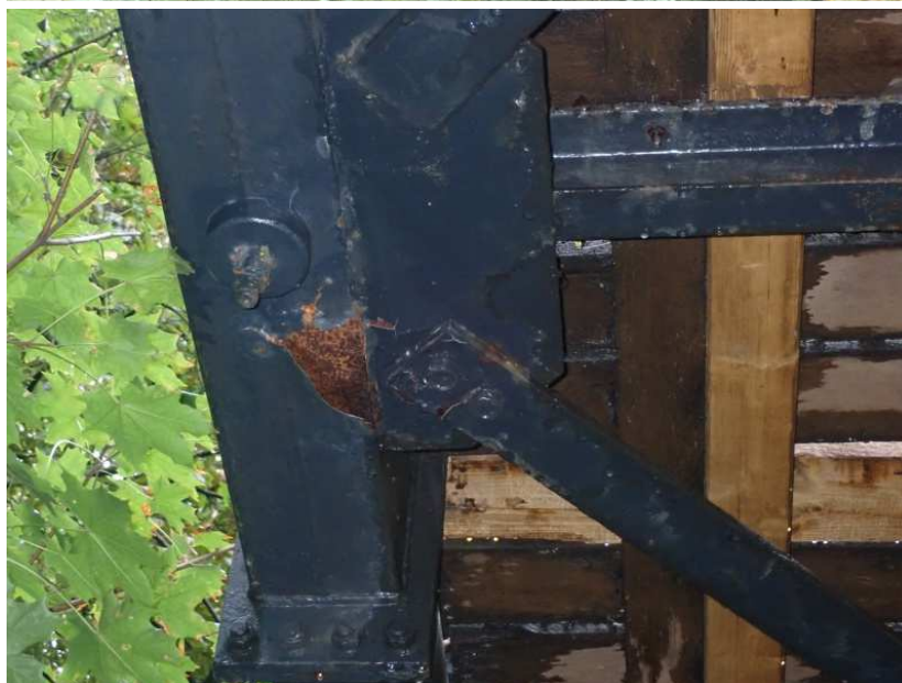
Ocel. prvky NK v pohledu napadeny korozí - vlevo
