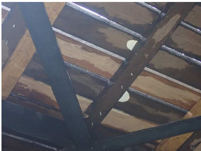
Podhled dřevěné mostovky s dřevokaznými houbami - vpravo
