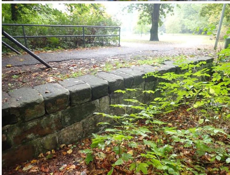
Pohled na výtokové křídlo vlevo – poškozené spárování a bez záchytného systému
