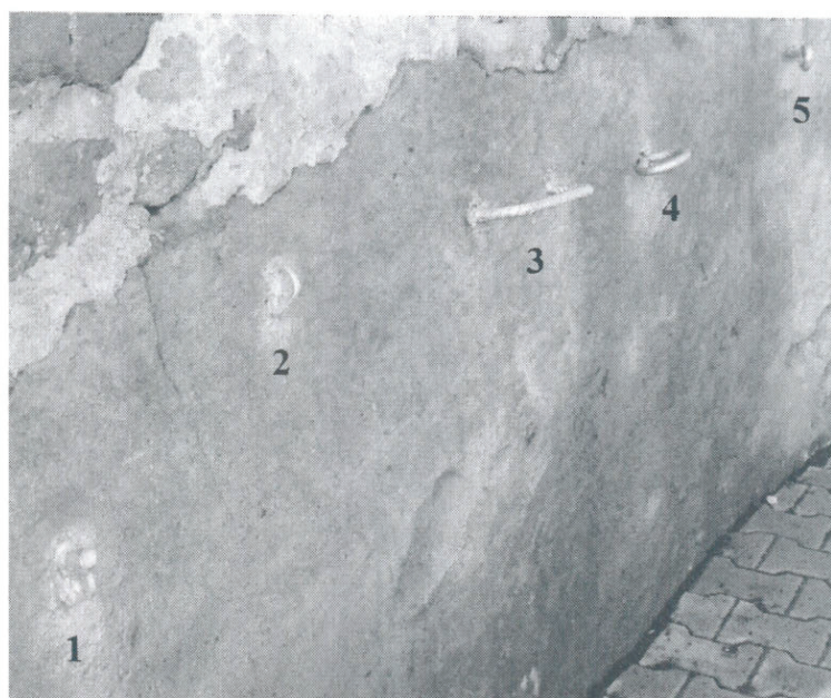
Obr. 6: Zkušební kotvy a oka u nástupního místa
