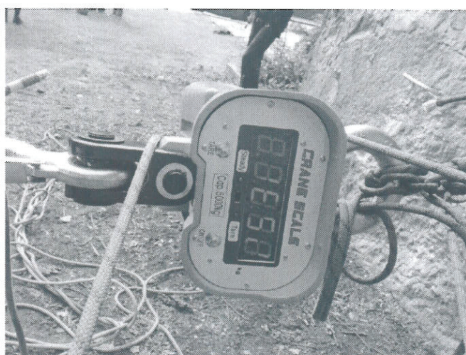
Obr. 7: Axiální zkouška na kotevním oku č. 5, naměřená požadovaná hodnota 1650 kg = 16,5 kN
