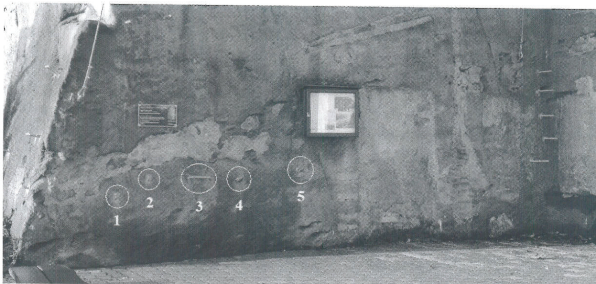
Obr. 5: Zkušební kotvy a oka u nástupního místa
