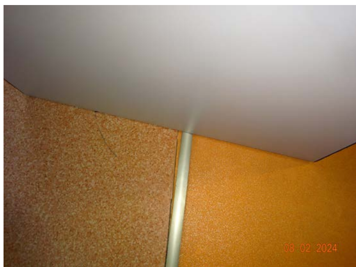
Místnost B211 – uvolněná přechodová lišta ve dveřích
