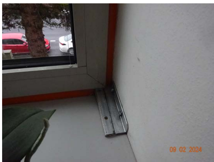
Pokoj C – zajištění okna zarážkou
