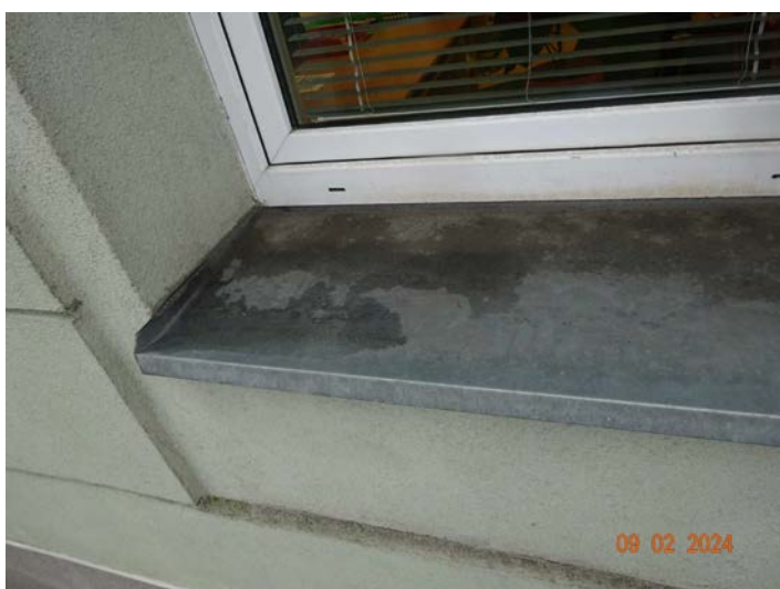
Objekt B – opačný sklon parapetu
