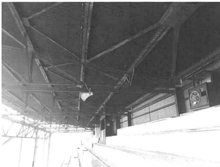
Ocelová konstrukce tribuny
