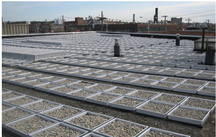
Obr. 31 Modrá střecha z plastových bloků (vlevo) [93] a modrá střecha se zásobníky vyplněnými štěrkem v New Yorku [94]
