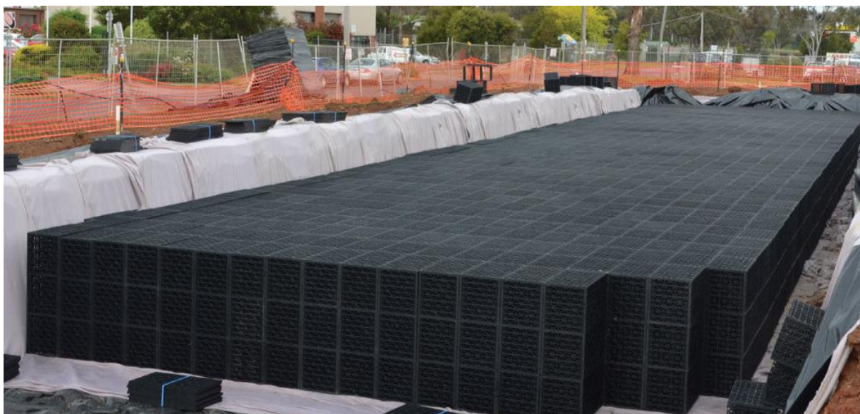
Obr. 33 Plastové bloky AS-NIDAPLAST [95]
