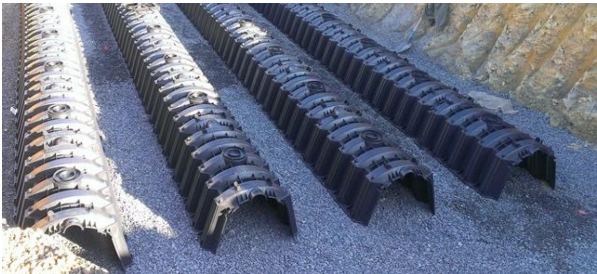
Obr. 32 Plastový vsakovací tunel GARANTIA [96]
