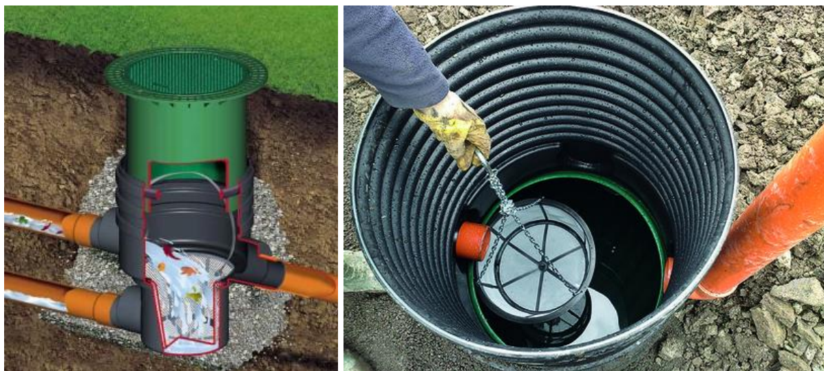
Obr. 24 Filtrační koš v tělese filtru [79, 80]
