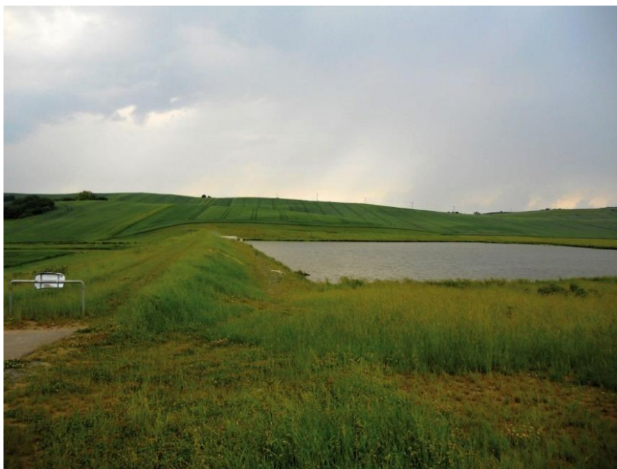
Obr. 28 Protierozní nádrž v Hustopečích [87]
