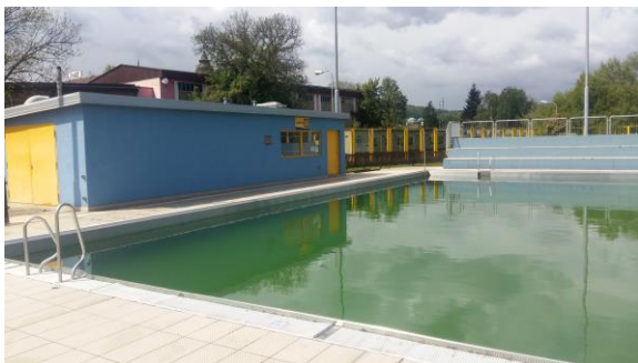
Obr. 48 Fotografie z místního šetření, pohled na venkovní 33m bazén
