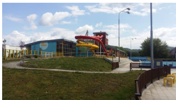
Obr. 43 Fotografie z místního šetření, pohled na plaveckou krytá halu
