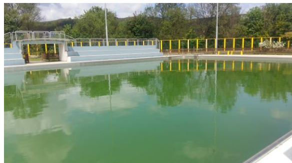
Obr. 49 Fotografie z místního šetření, pohled na venkovní 33m bazén
