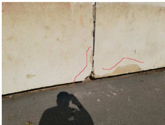
18. detail parapetního panelu s poškozeným rohem a odpadávajícím štukem
