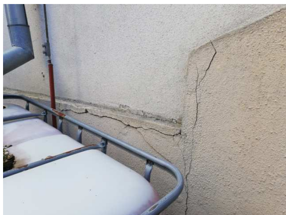
14. trhliny na styku základu a zdiva spojovací chodby
