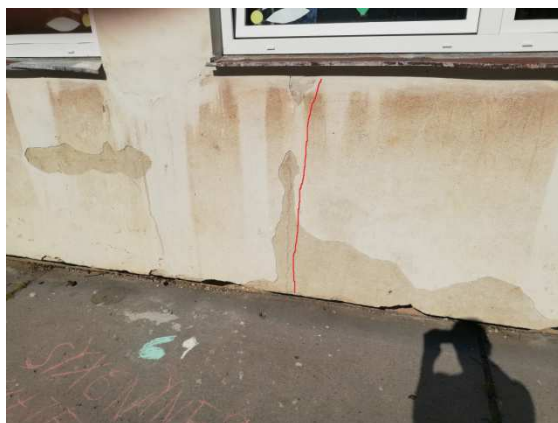
16. detail parapetního panelu s vlasovou trhlinou
