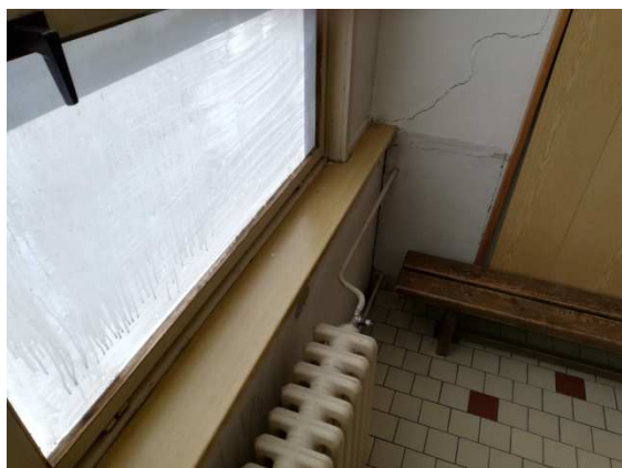
13. okenní výplně s parapety a patrnou trhlinou přičky
