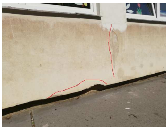
17. detail parapetního panelu s vlasovou trhlinou a poškozenými hranami
