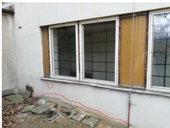
10. stav meziokenních vložek a okapových chodníků dvorní fasády a patrná vztlínající vlhkost na fasádě
