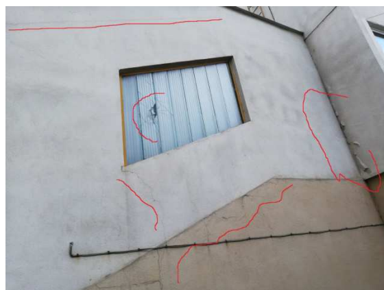
6. detail spojovací chodby s vyznačenými poruchami
