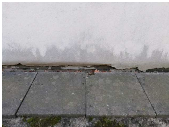
12. Detail ukončení vodorovné izolace v místě napojení okapového chodníčku
