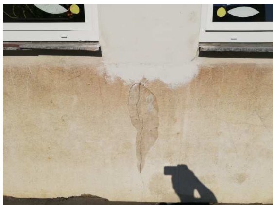
19. Detail trhliny v parapetním panelu a odpadávajícím štukem v místě trhliny
