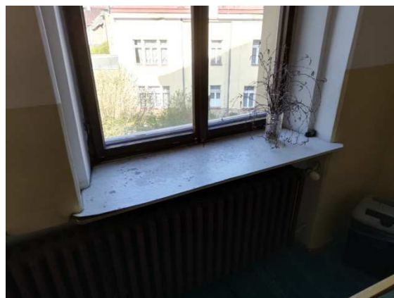
35. Dřevotřískové parapety oken v kabinetech
