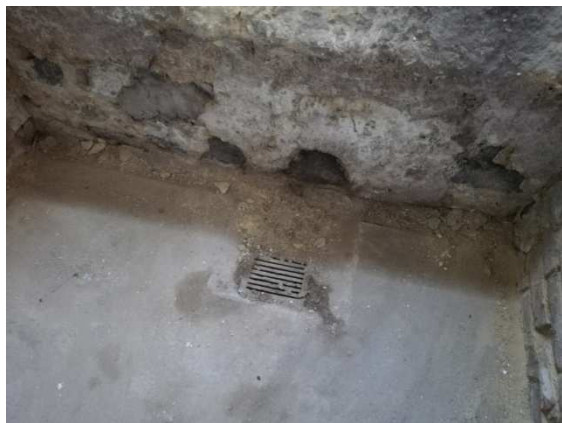
44. Vpusť a odvodňovací žlábek podél uliční fasády v 1.PP
