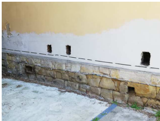
24. Podříznutí zdiva nepodsklepené části s opravovanou omítkou
