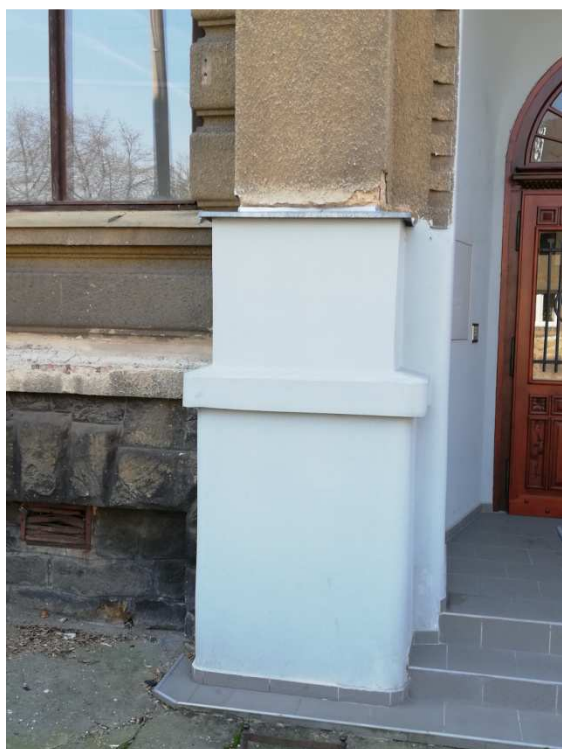
11. Opravené schodiště a patka pilastru uliční fasády
