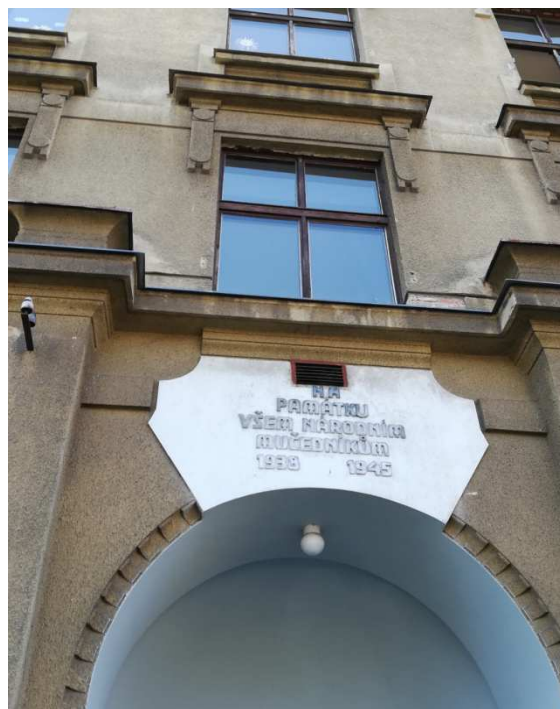
12. Detail portálu vstupu, kordonové římsy, suprafenster a parapetních říms.
