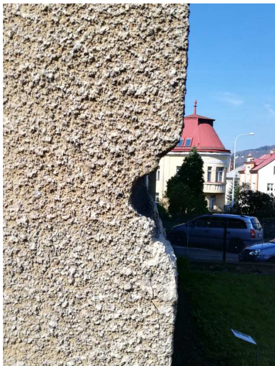
8. Detail tvaru rustiky a struktury březolitévé omítky
