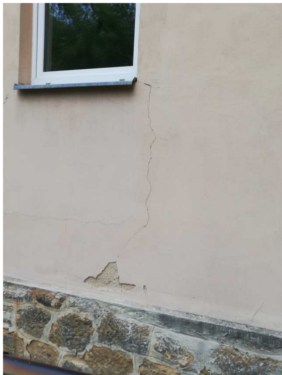
26. Trhlina ve zdivu schodišťového křídla
