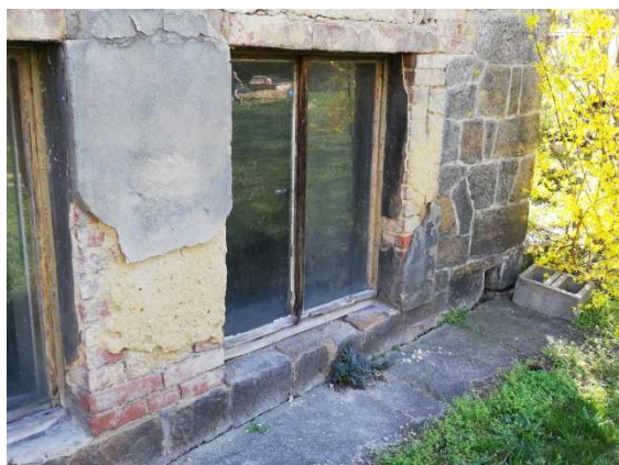
34. Stav soklu západní fasády s vlhkostí degradovaným omítkami cihelného zdiva
