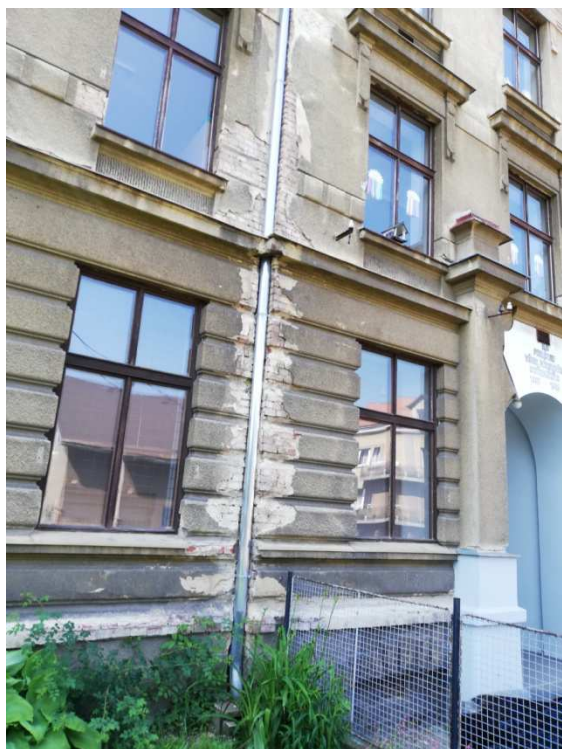
7. Detail uliční fasády s narušenými omítkami v místech dříve netěsných dešťových svodů
