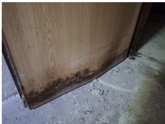
45. Vlhkostí poškozené vstupní dveře do 1.PP
