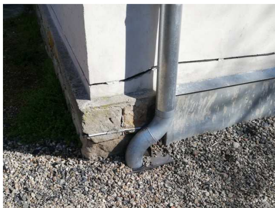
25. Podříznutí zdiva nepodsklepené části
