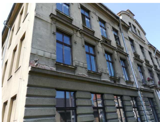
5. Detail výzdoby uliční fasády s patrnou degradací omítek vlivem ostřikující vody nad kordonovou římsou
