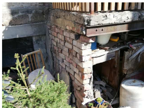
22a. Stav zdiva podporujícího balkon bytu školníka
